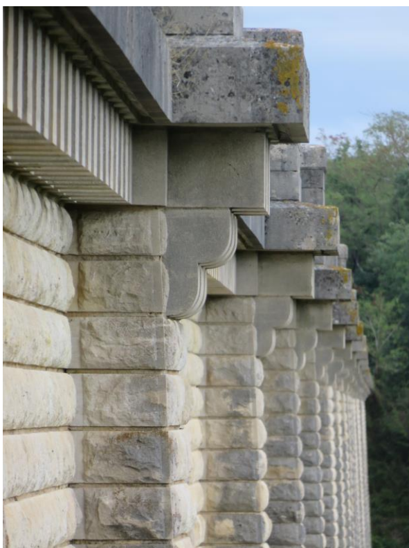
Détail des modénatures sous le parapet
