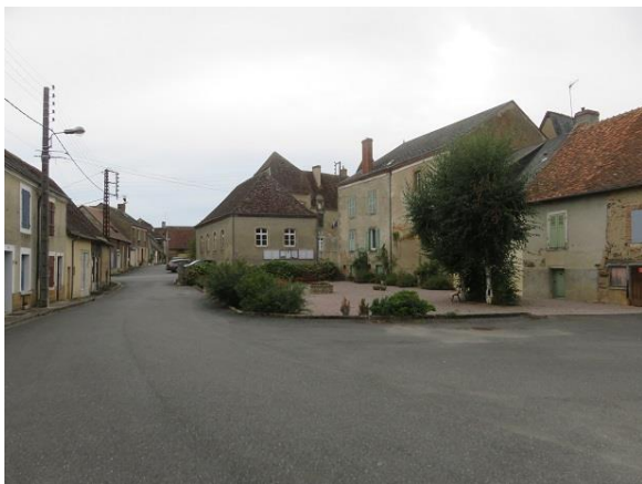
Vue vers le manoir depuis la Rue des Fossés
