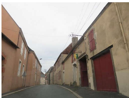
Bâti ancien, Route d'Orsennes
