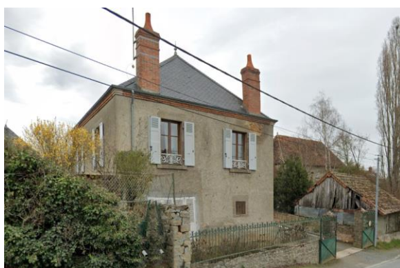
Maison de maître, Route de Mouhers
