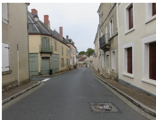
Bâti ancien, Rue Grande
