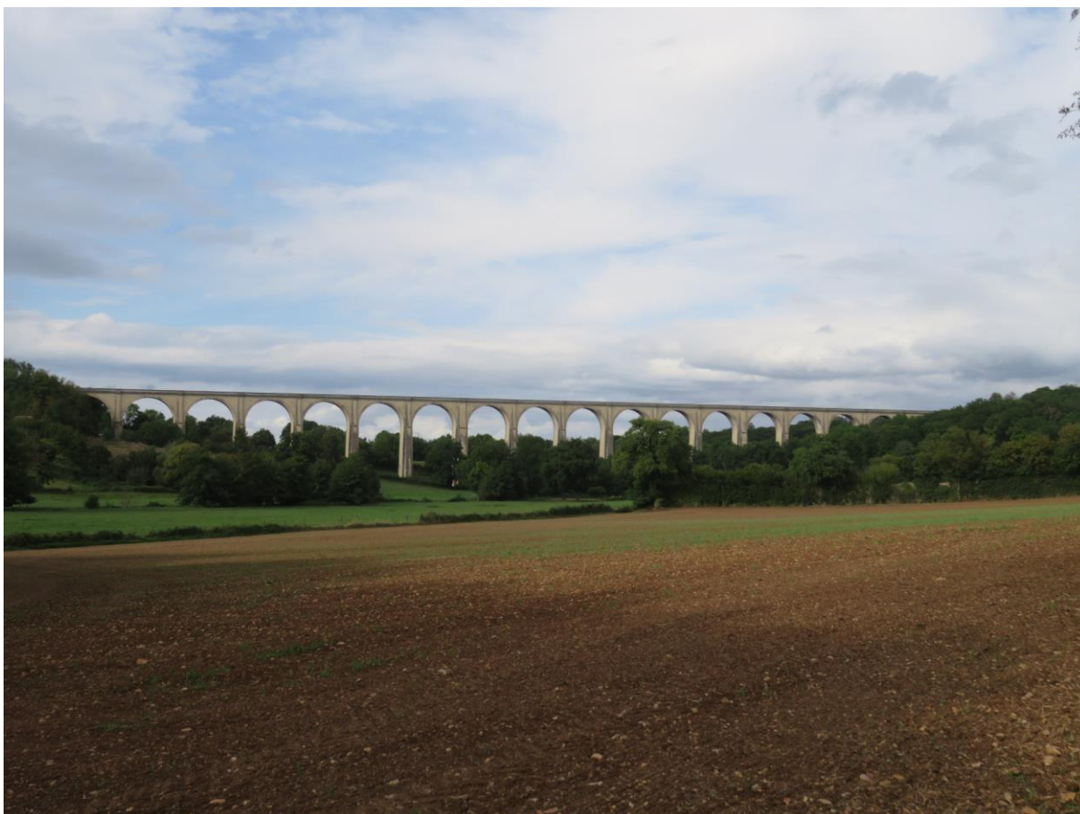
Vue sur le viaduc de l'Auzon
