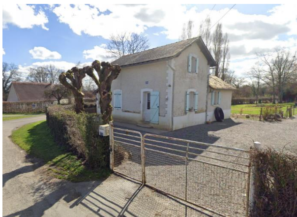
Ancienne maison de garde barrière, l'Augère
