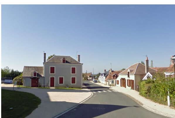
Bâti ancien, Rue de la Renaissance
