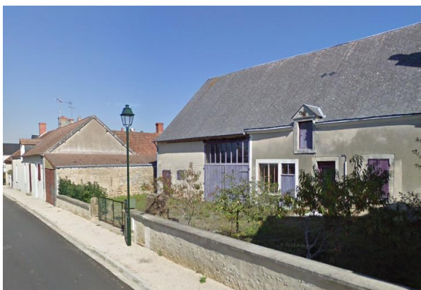
Bâti ancien, Rue du champ de Foire
