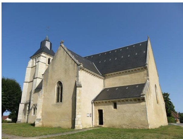
Vue de l'église Saint-Martin depuis le Sud
