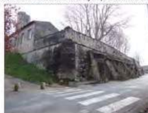
Mur de soutènement de la terrasse ouest (cl. C. Herbaut)
