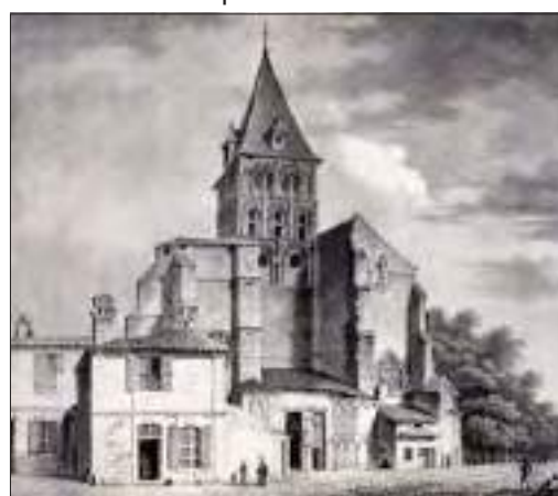
Eglise Saint-Seurin, façade occidentale avant sa restauration, gravure du XIX e siècle (Arch. municipales de Bordeaux, Fi XIX-G-8)
