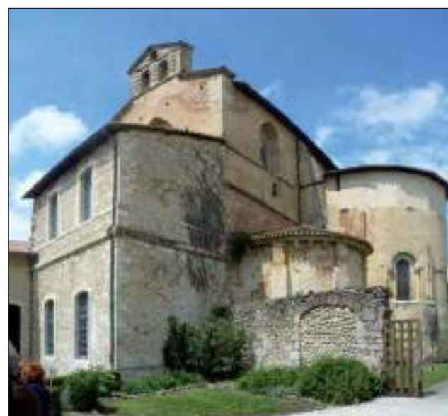
Vue du transept sud et des absides et du chevet de l'abbatiale (cl. G.-H. Bailly)
