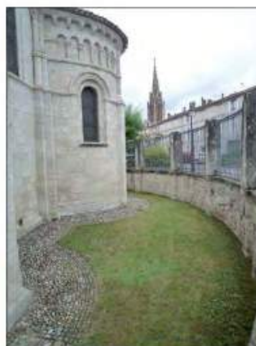
Le décaissé entre le chevet et ses grilles (cl. G.-H. Bailly)
