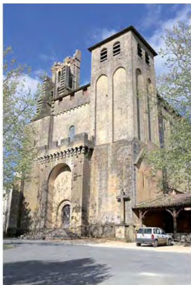
La façade occidentale de l'église et sa tour sud-ouest (cl. G. Danet)
