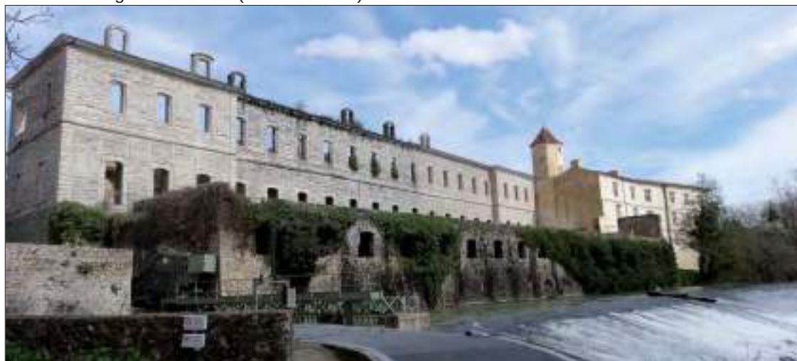
Vue sud-ouest depuis le moulin : terrasse sur le crypto-portique des celliers, bâtiment du réfectoire et du parloir, au fond le logis de l'abbé (cl. C. Herbaut)
