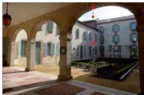
Aile nord et cour de l'ancien monastère, devenu grand séminaire au XVIII e s. La sacristie (A) est dans l'angle du transept sud (B) (cl. C. Herbaut)
