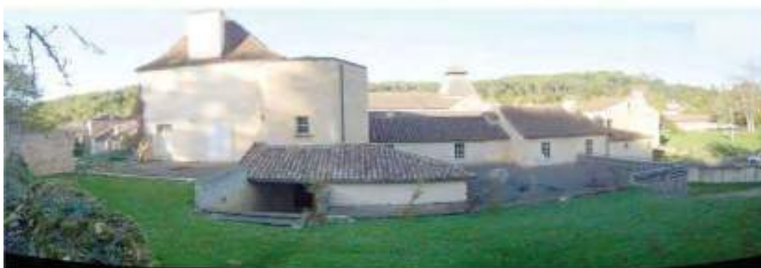
14 - Au sud encore, le terrain avec accès semi enterré à la tour (cl. G.-H. Bailly)
