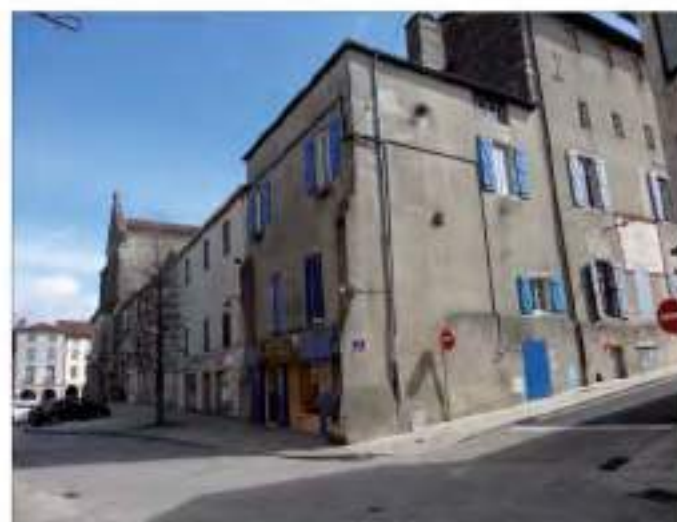
3 - Angle des ailes ouest et sud, bâtiments transformés en habitations après la Révolution (cl. C. Herbaut)
