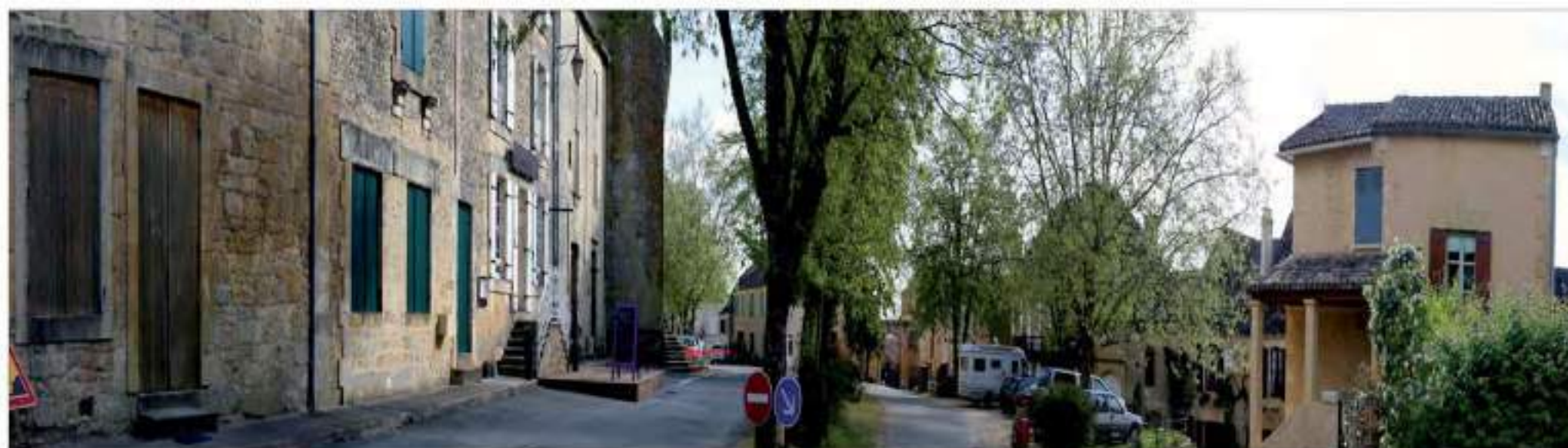
5 - Vue depuis le nord sur la place du bourg située à l'ouest de l'ancenne abbatale dont l'entrée est indiquée par la flèche rouge (cl. G. Danet)
