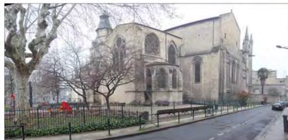
Vue du chevet donnant sur la rue Rodrigues Péreire (cl. C. Herbaut)
