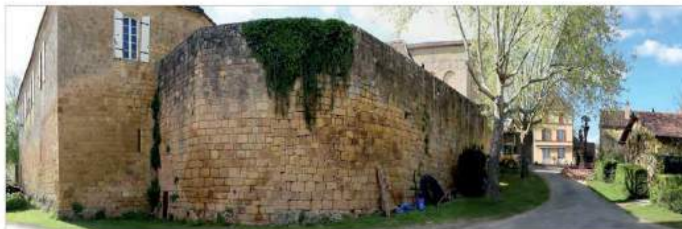
7 - Vue sud-est du mur de clôture de l'ancienne abbaye (cl. G. Danet)
