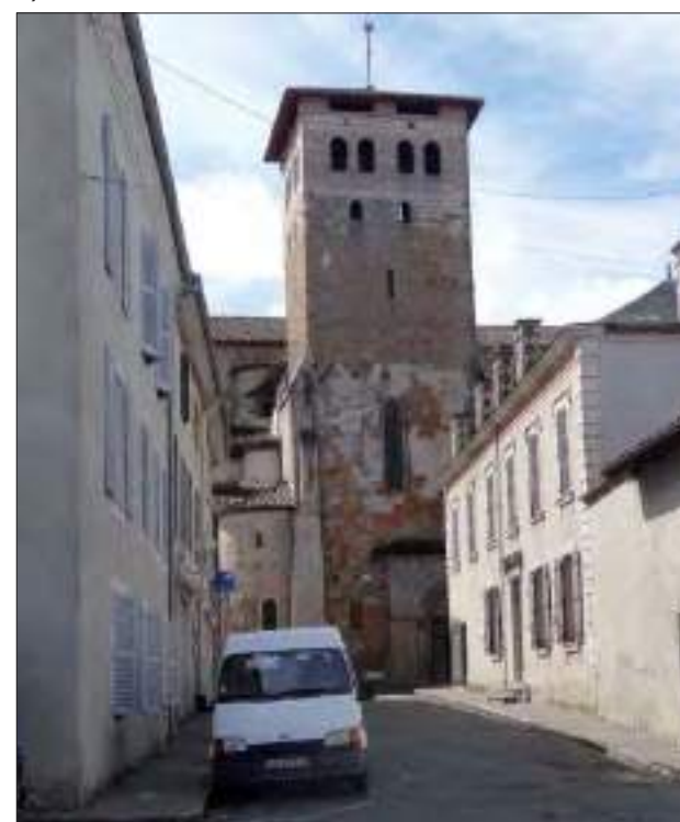
Façade nord et clocher de l'abbatiale, depuis la rue du Tribunal (cl. C.Herbaut)
