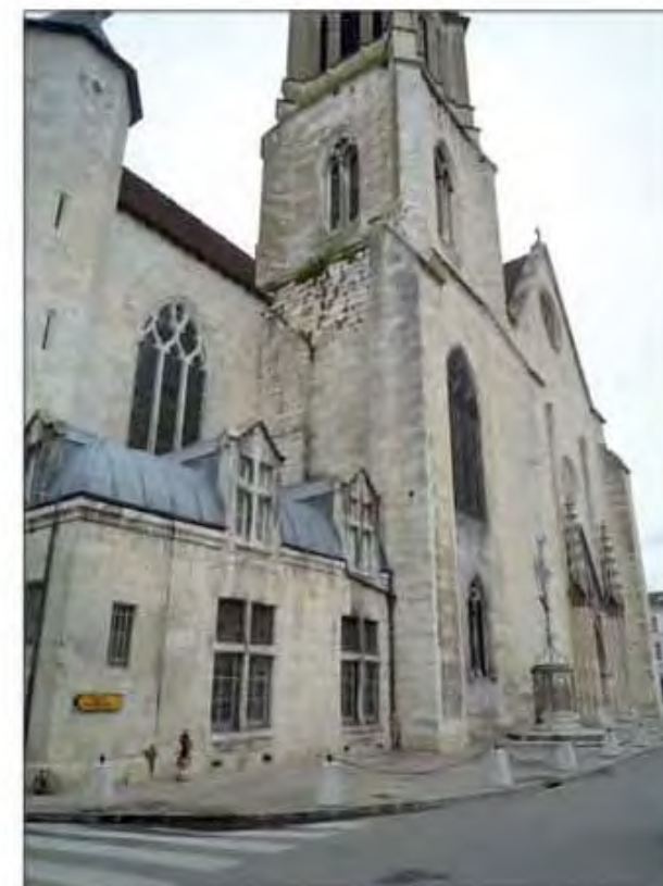
La façade sud vue depuis la rue des Augustins (cl. G.-H. Bailly)
