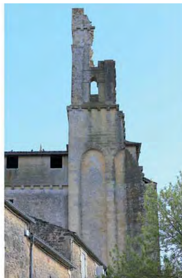
La tour nord-ouest de l'église (cl. G. Danet)
