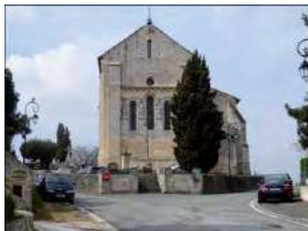
Angle de la rue de l'Eglise et de la voie communale (cl. C. Herbaut)
