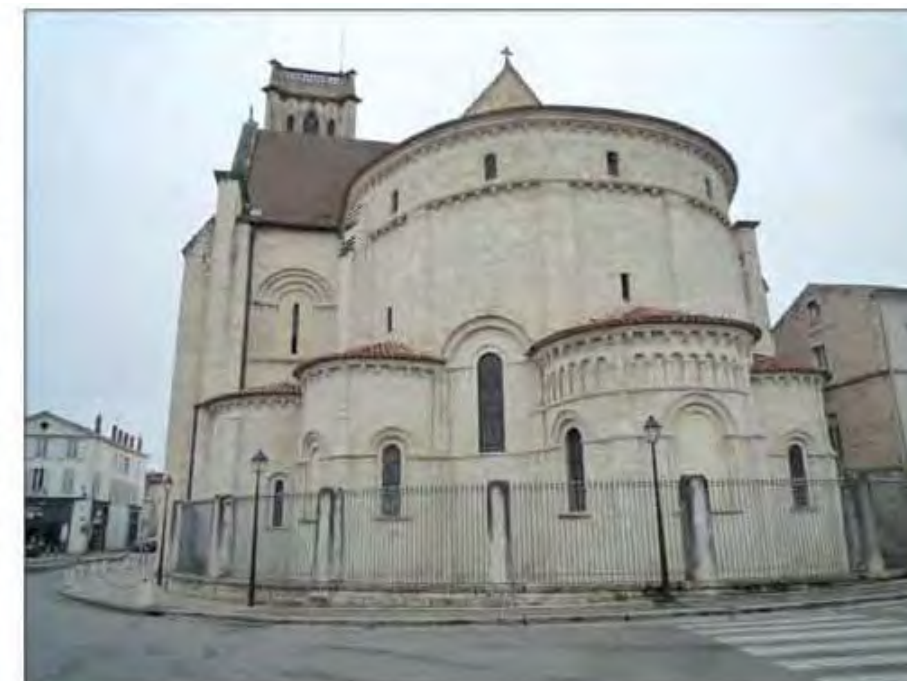
Le chevet vu depuis le débouché de la rue de la Commune de Paris (cl. G.-H. Bailly)
