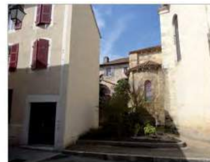
6 - Vue des deux absidioles sud (cl. C. Herbaut)
