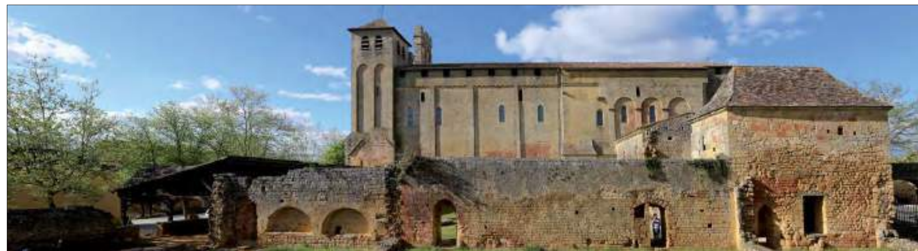
Vue générale sud de l'église et du mur séparant le cloître de la cour de la maison des chanoines (cl. G. Danet)
