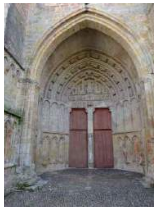
Portail occidental (cl. C. Herbaut)
