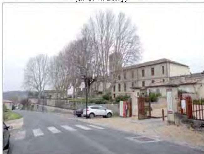
Mur de soutènement et grille de clôture sur la rue de l'Abbaye (cl. C.-Herbaut)
