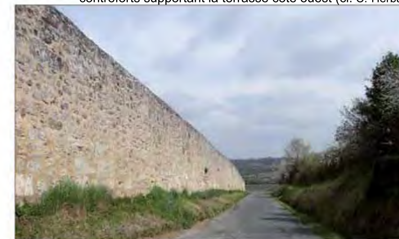
Le mur de clôture de l'abbaye à l'est le long de la rue du Tour-de-Ronde Saint-Gérard (cl. C.-Herbaut)
