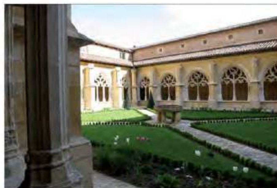
Vue générale sud-ouest du cloître (cl. G. Danet)
