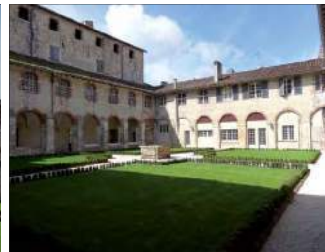
Aile ouest, habitations ouvrant sur le cloître, et vers l'ouest sur la place du Tour-du-Sol (cl. C. Herbaut)
