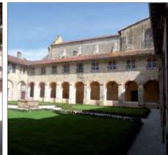
Aile nord, galerie donnant accès à la place du Tour-du-Sol (cl. C. Herbaut)
