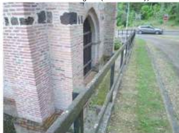
Le décaissé du terrain au nord-ouest du clocher le long du chemin côtier (cl. G.-H. Bailly)
