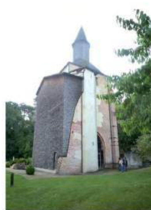
Façades nord-est du clocher-porche (cl. G.-H. Bailly)
