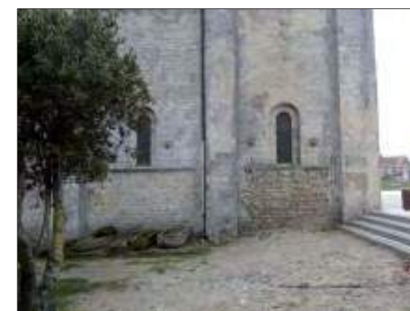
Façade nord au pied de laquelle sont déposés les sarcophages mis au jour lors du dégagement de la dune autour de l'église. A noter le dénivelé avec l'esplanade ouest récemment aménagée (cl. C. Herbaut)
