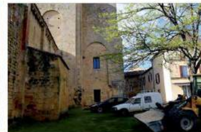
8 - L'ancienne salle capitulaire, à gauche, et le sud du chœur (cl. G. Danet)
