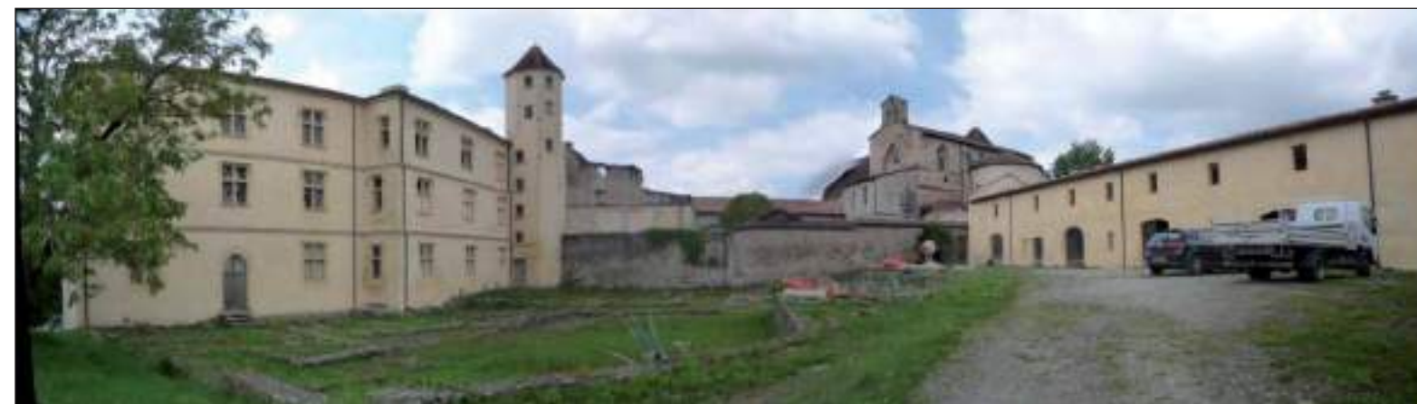
Vue panoramique sur la cour du logis de l'abbé (à gauche), les communs (à droite) et l'abbatiale (en arrière plan) (cl. G.-H. Bailly)
