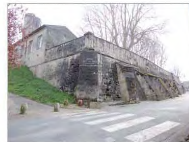
Angle de cette allée et de la rue de l'Abbaye et ses contreforts supportant la terrasse côté ouest (cl. C.-Herbaut)
