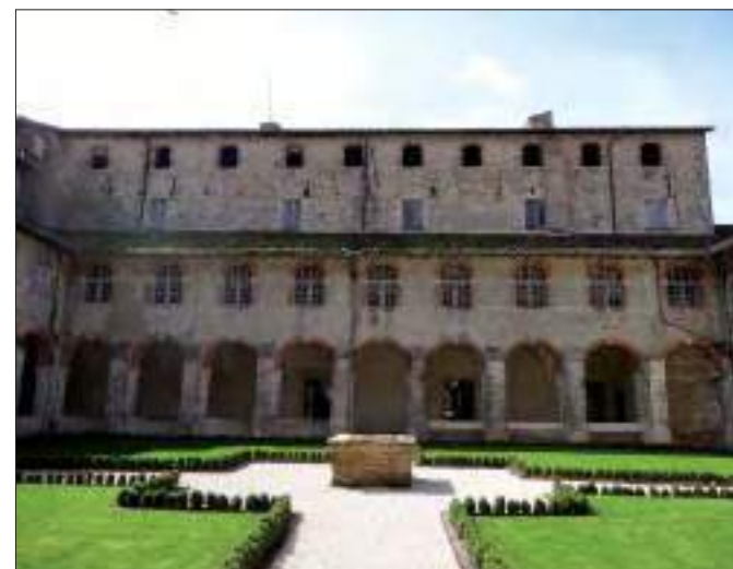
Aile sud occupée par la mairie, les anciens dortoirs et greniers sont vacants (cl. C. Herbaut)
