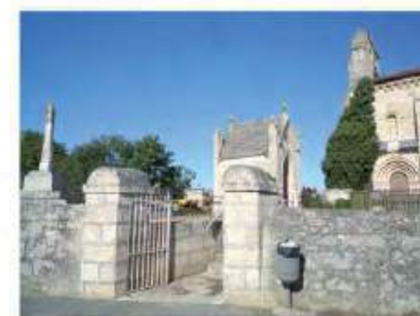
Escalier de l'angle des rues de l'Eglise et du Cimetière (cl. G.-H. Bailly)
