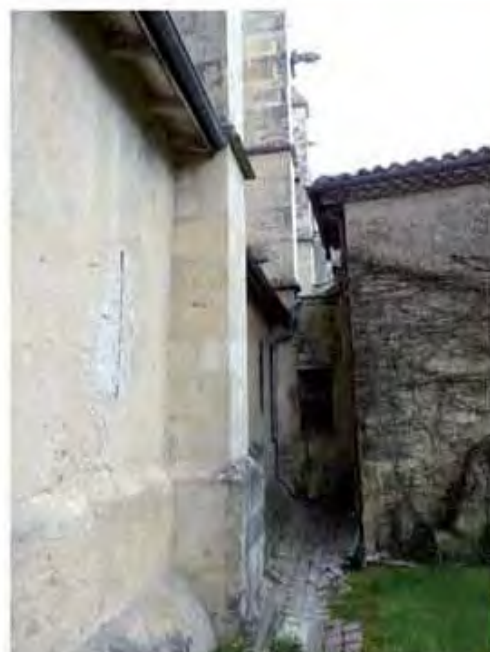
Appentis non accolés au mur de la nef
