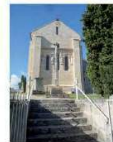
Escalier de l'angle de la rue de l'Eglise et de la voie communale
