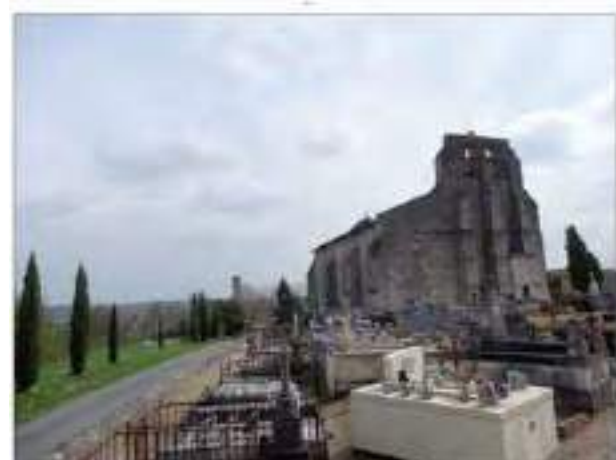
Mur nord du cimetière et façade ouest de l'église (cl. C. Herbaut)
