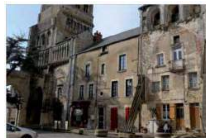
Vue sur les maisons construites sur l'ancien bas-côté nord (cl. G. Danet)
