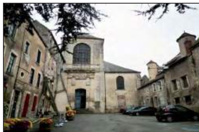
Vue sur de la place Sainte-Croix, cour intérieure à l'emplacement de la partie de la nef et du bas-côté sud démolis (cl. G.-H. Bailly)
