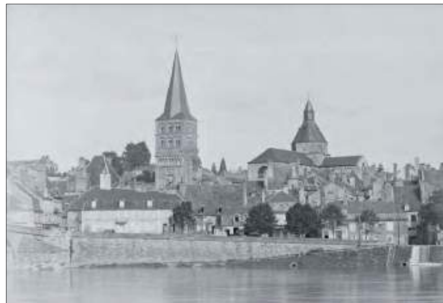
Vue générale sud-ouest au début du XX e siècle (d'après Arch. départementales de la Nièvre, 19J 28, non daté)
