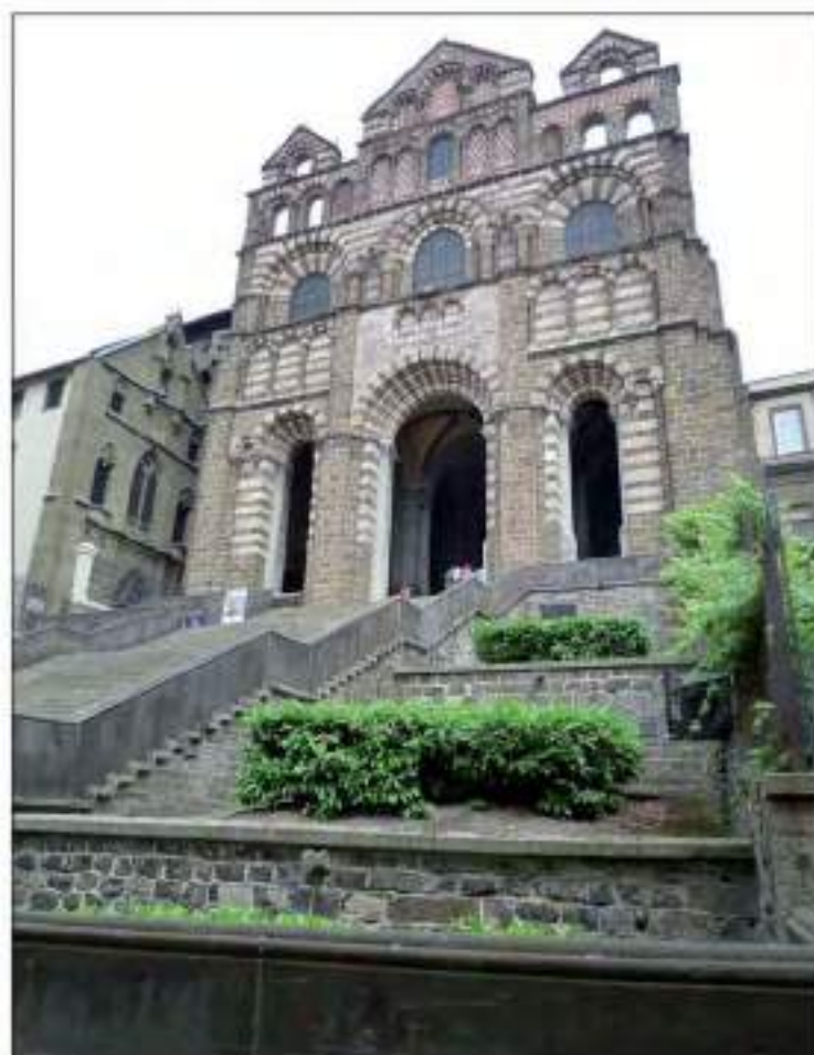
Façade occidentale et grand escalier (cl. G.-H. Bailly)
