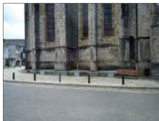
Les banquettes entre les contreforts du chevet (cl. G.-H. Bailly)
