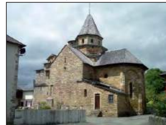
Façade sud de l'église et sacristie (cl. G.-H. Bailly)
