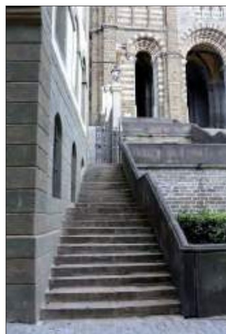
L'escalier latéral de l'hôtel-Dieu (cl. G. Danet)
