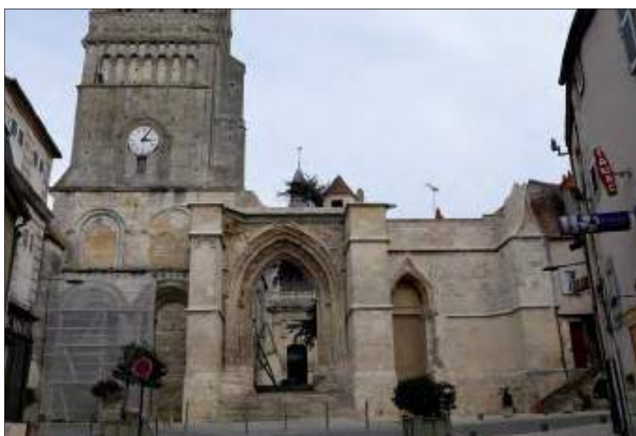
Vue générale ouest de la tour de clocher et des vestiges de la façade (cl. G. Danet)
