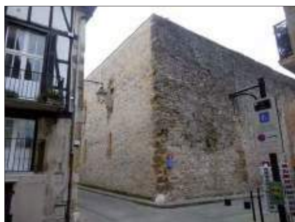
6 - Cloître, angle sud-ouest du mur (cl. C. Herbaut)
