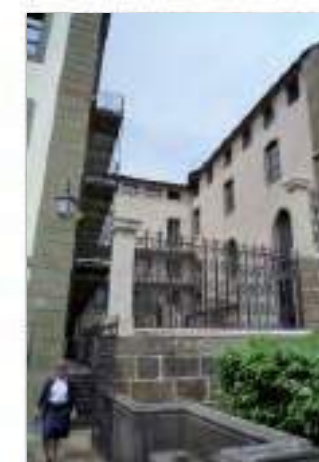
3 - La cour donnant sur l'escalier ouest (cl. G.-H. Bailly)
