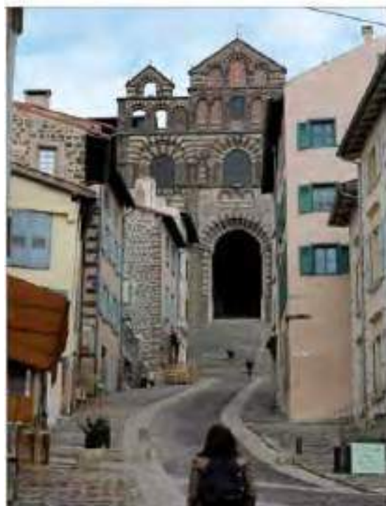
Vue générale ouest (cl. G. Danet)
