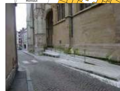
11 - Portail nord et sa rampe, rue Notre-Dame (cl. C. Herbaut)
