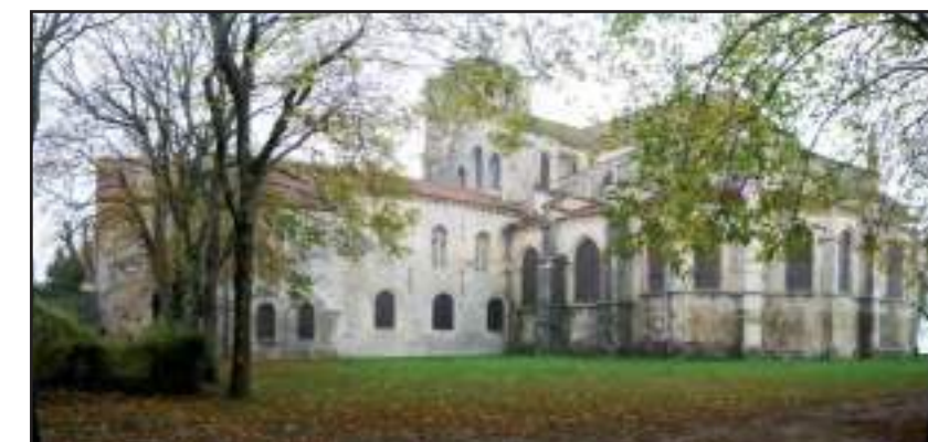
Façade est du bâtiment conventuel de la salle capitulaire et chevet de la basilique (cl. G.-H. Bailly)
