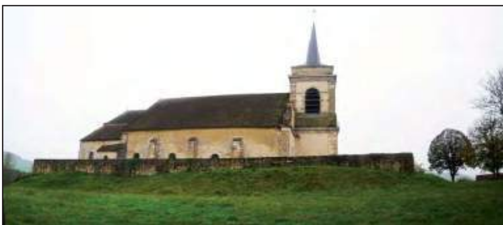
La façade nord de l'église Saint-Jacques d'Asquins entourée de son enclos sur sa terrasse ceint d'un muret de clôture (cl. G.-H. Bailly)
