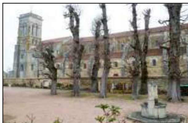
Façade sud de la basilique au-delà de la parcelle AB 484 (cl. G. Danet)
