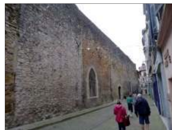
7 - Cloître, mur sud rue De Luc (cl. C. Herbaut)
