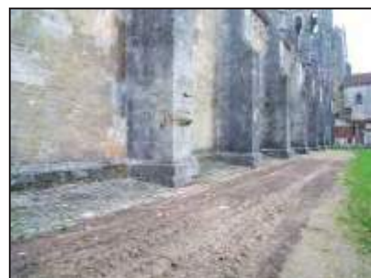
Banquettes pavées au pied de la façade sud de la basilique (cl. G.-H. Bailly)
