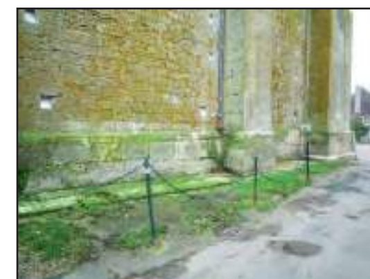
Banquettes pavées au pied de la façade nord de la basilique (cl. G.-H. Bailly)
