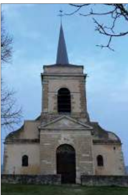
Façade ouest (cl. G. Danet)
