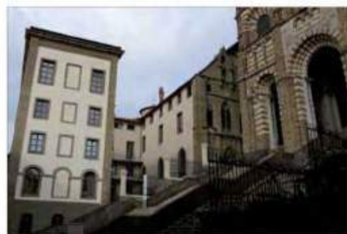
1 - Vue générale sud des façades (cl. G. Danet)
