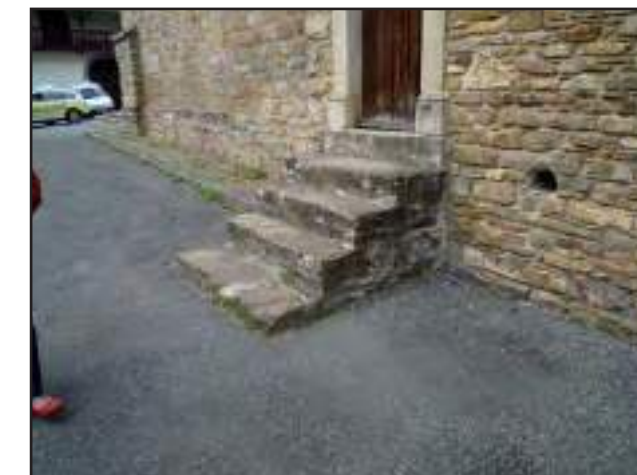
Escalier d'accès à la sacristie débordant sur la place (cl. G.-H. Bailly)
