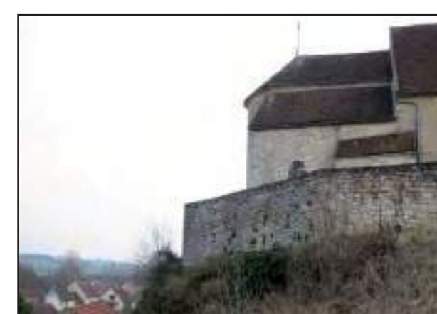
Soutènement est de la terrasse au chevet de l'église (cl. G. Danet)
