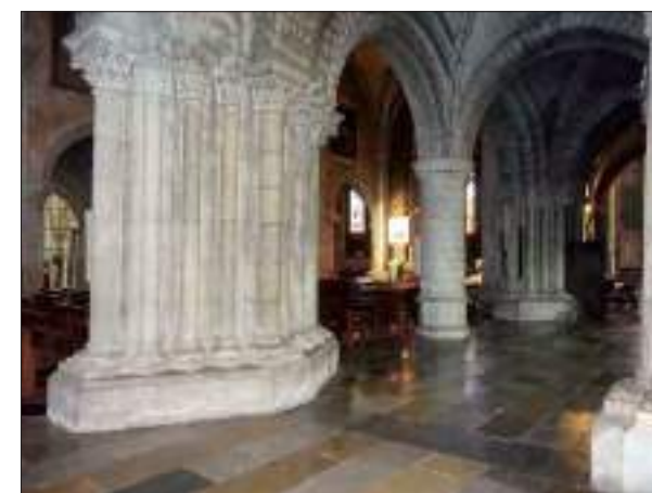
Vue intérieure dans le collatéral sud, piliers et pile du XIV e siècle (cl. C. Herbaut)
