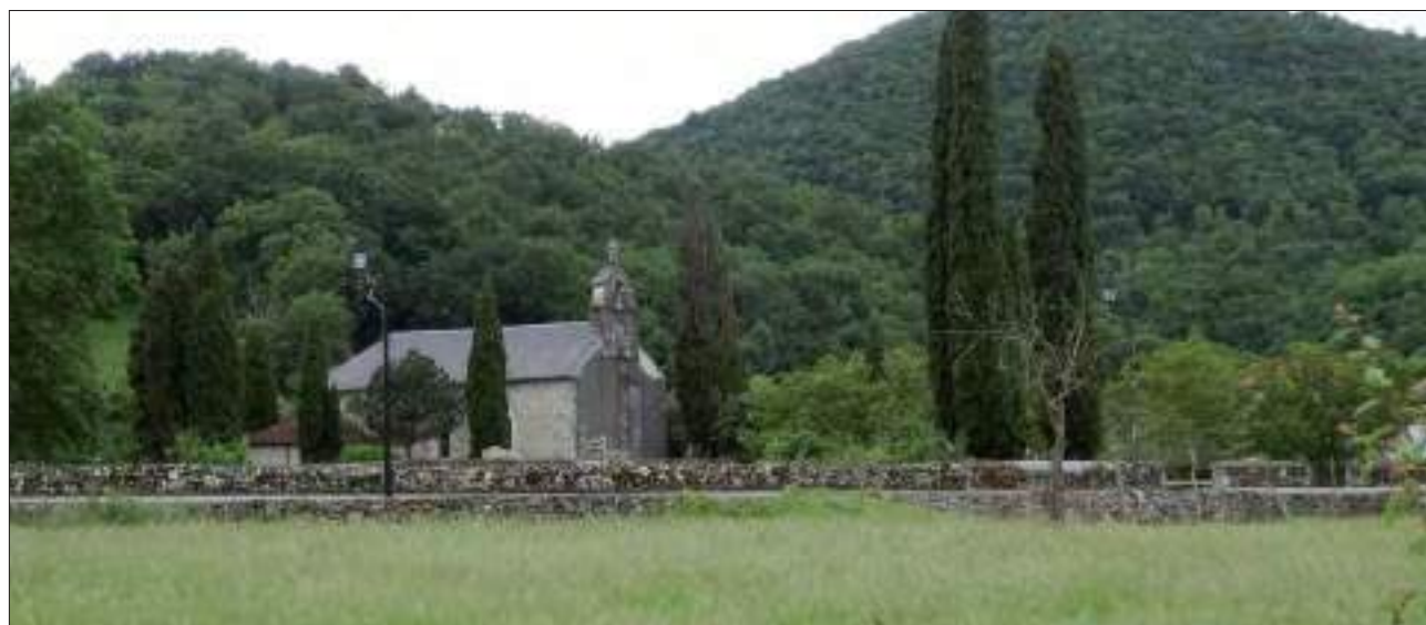
Vue générale nord du site du Plan (cl. C. Herbaut)
