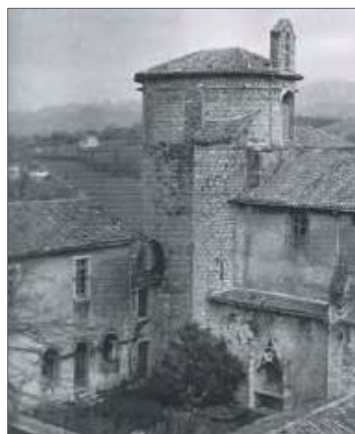
Vue aérienne du cloître de la Sède avant la démolition de l'aile ouest, en bas à droite, années 1960 (d'après A. ORTET, Un asile d'aliénés... , p. 31, cl. J.-P. Bareille)
