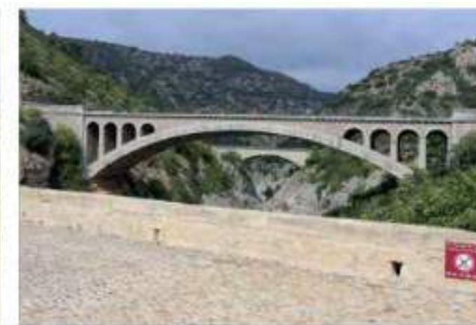
En amont du pont du Diable, le pont Neuf et, à l'arrière plan, l'acqueduc (cl. G. Danet)
