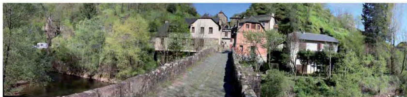
Le pont vu depuis son accès ouest (cl. G. Danet)
