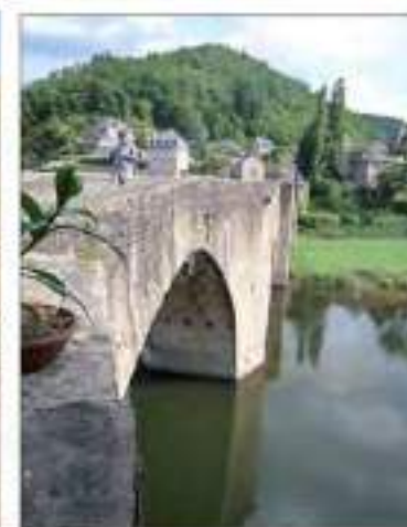
Face aval du pont (cl. G. Danet)
