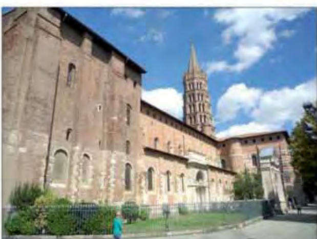
La façade sud de la nef cernée de grille (cl. G.-H. Bailly)
