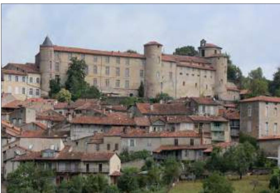
Vue générale sud de l'ancien palais épiscopal et de l'ancienne cathédrale Notre-Dame-de-la-Sède construits sur les remparts (cl. G. Danet)
