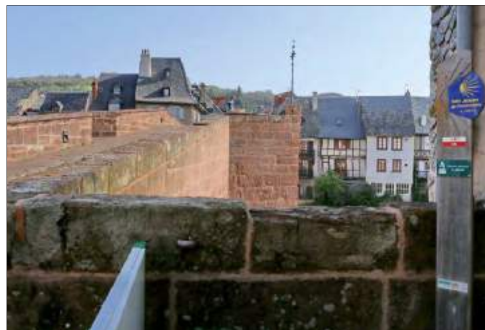
Le bout du pont au sud (cl. G. Danet)
