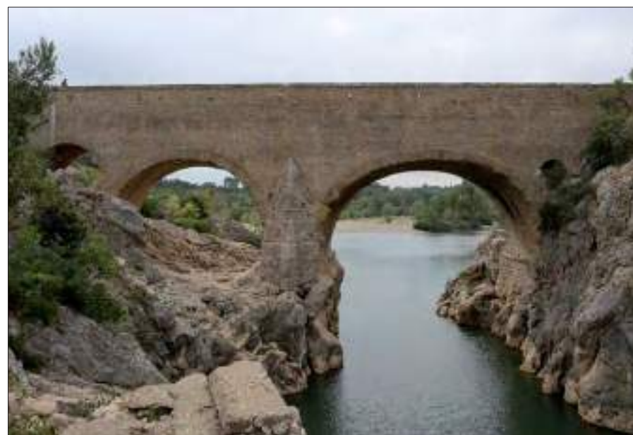
Vue générale nord, en amont (cl. G. Danet)
