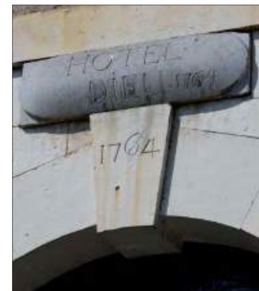
2 - Pavillon est, porte d'entrée datée 1764 (cl. G. Danet)
