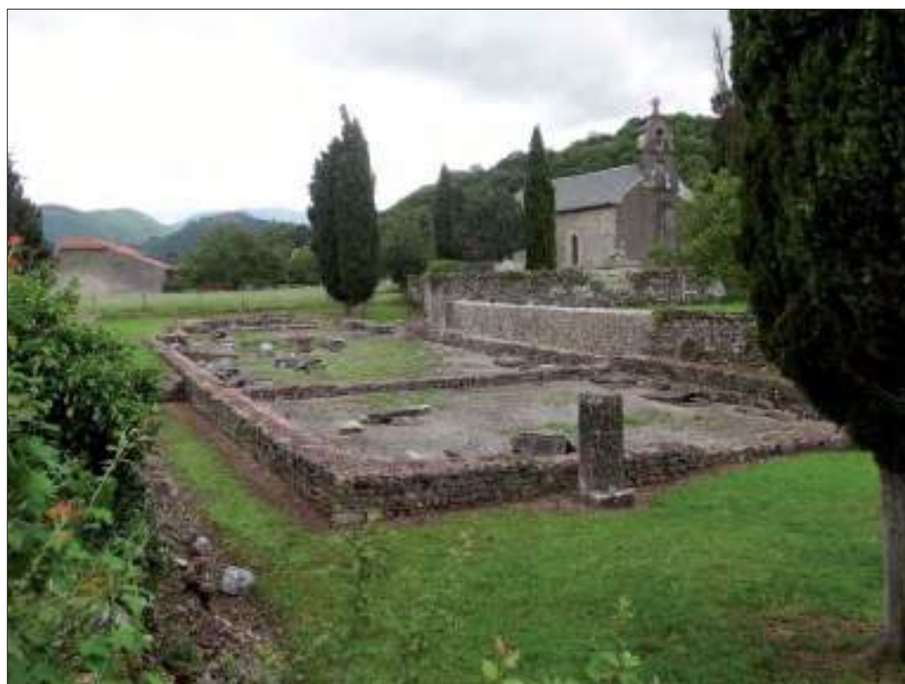
Vue générale nord-ouest de la basilique paléo-chrétienne et de la chapelle Saint-Julien en arrière-plan (cl. C. Herbaut)
