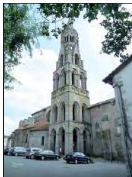
Façade nord et clocher-porche (cl. G.-H. Bailly)
