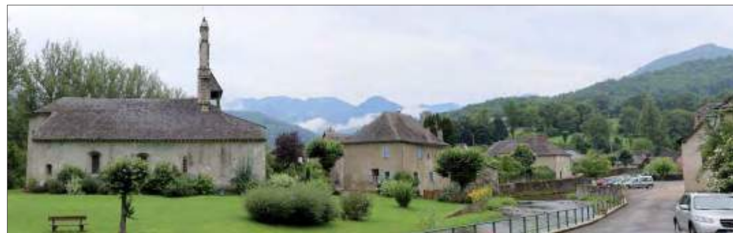
4 - Vue générale nord (cl. G. Danet)
