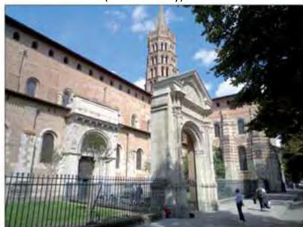
Le portail sud de la nef et le portail de la grille (cl. G.-H. Bailly)
