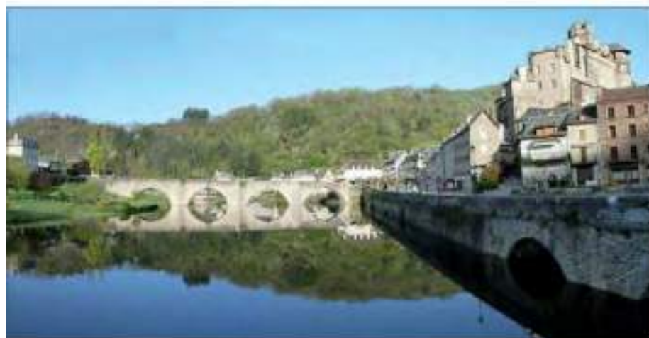
Le plan d'eau du Lot et le pont en amont (cl. G. Danet)
