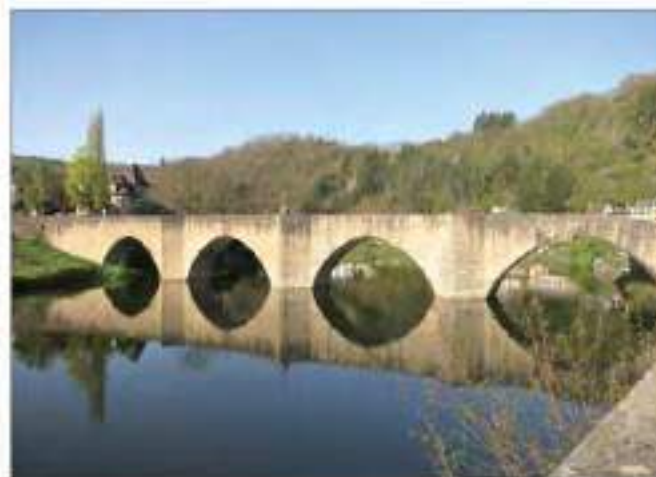
Le pont vu du quai du Lot (RD 920) (cl. G. Danet)
