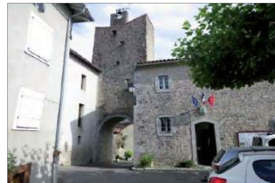
5 - Porte de l'Horloge vue depuis la place de la Mairie (cl. G. Danet)
