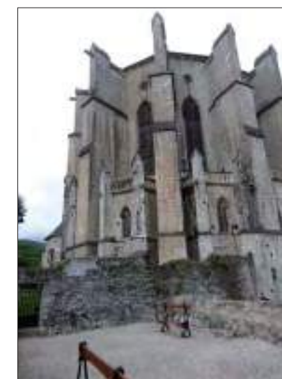
10 - Vue nord-est sur le chevet (cl. C. Herbaut)
