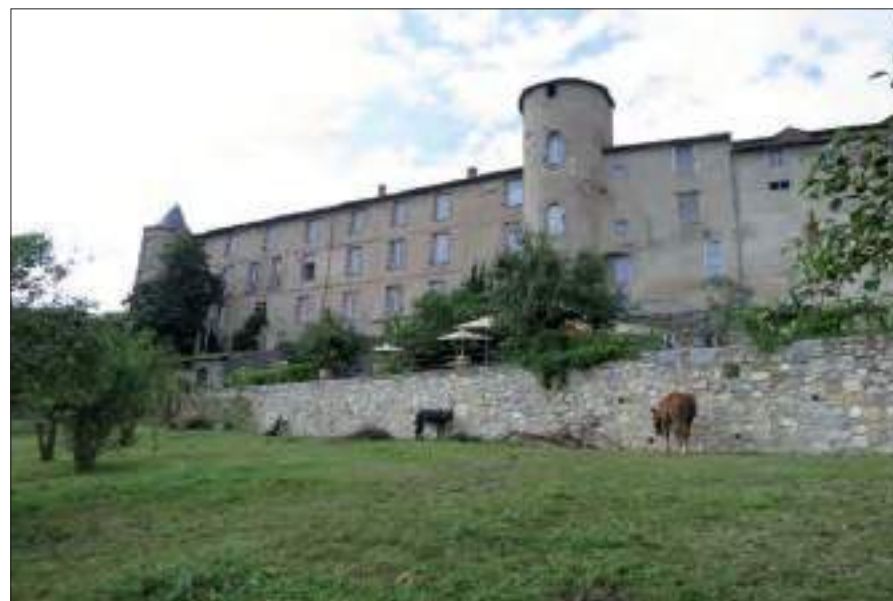
1 - Vue générale sud de l'ancien palais épiscopal (cl. G. Danet)
