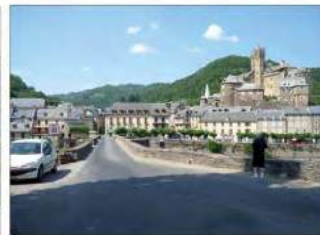
Le tablier du pont vu de la rive sud (cl. G.-H. Bailly)
