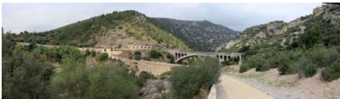
Vue vers le nord, du pont du Diable et du pont Neuf depuis le chemin venant du parking (cl. G. Danet)
