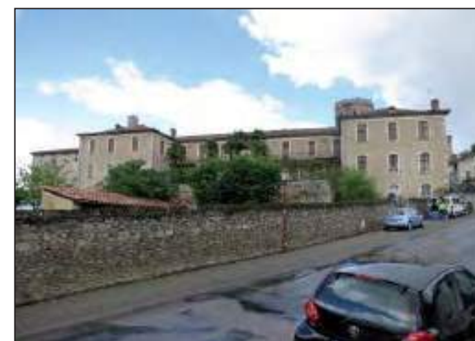
Vue de la façade sud de l'hôtel-Dieu depuis la rue de l'Hôtel-Dieu (cl. G. Danet)
