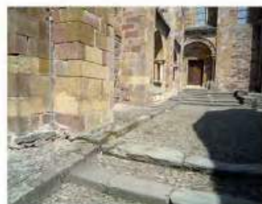
8 - Escalier d'accès au portail du croisillon sud (cl. G.-H. Bailly)
