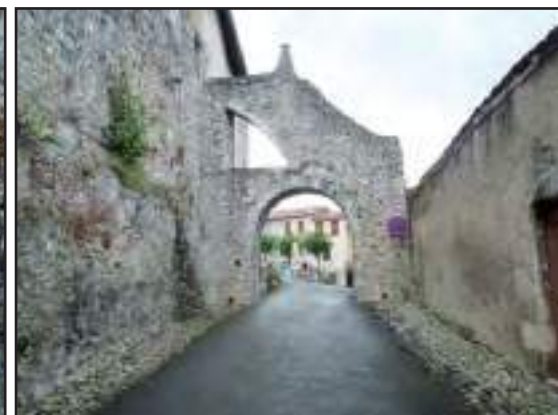
Le même soutènement et son contrefort, rue du Bout-du-Pont (cl. G.-H. Bailly)
