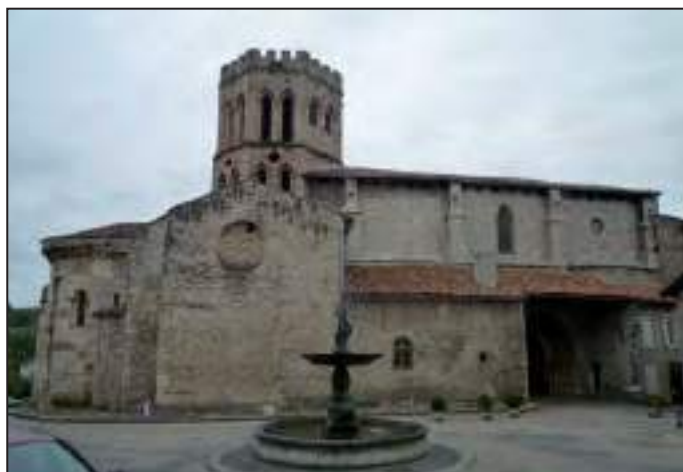
Elévation de la façade nord de la cathédrale (cl. G.-H. Bailly)
