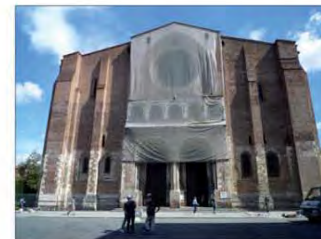
La façade occidentale actuellement en travaux (cl. G.-H. Bailly)
