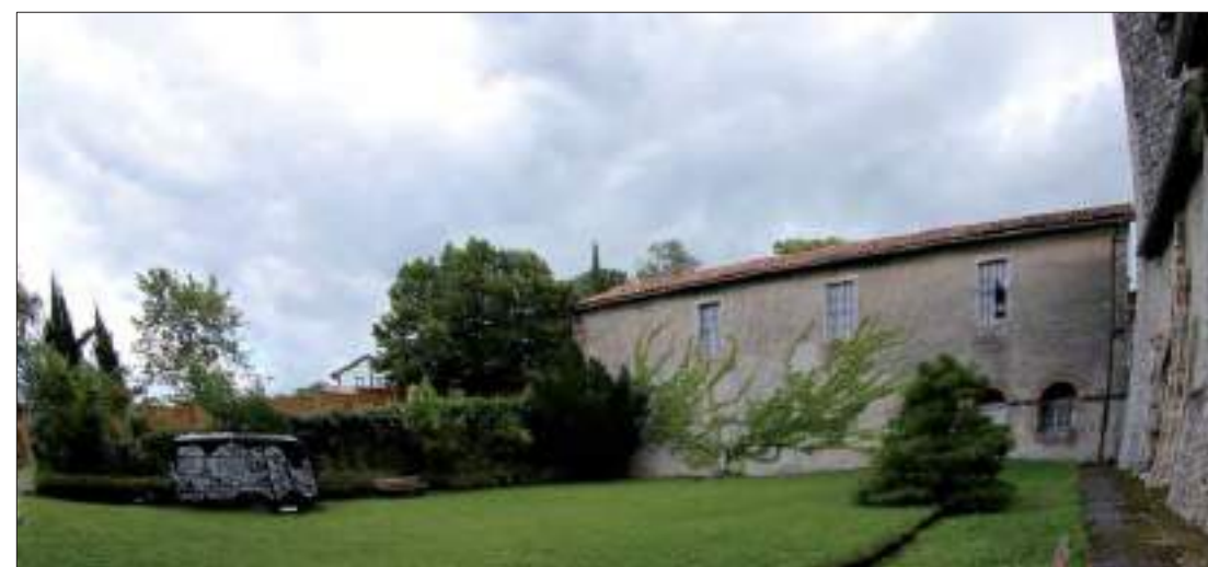
4 - L'emplacement du cloître depuis le porche de l'église avec, en face, l'aile de la salle capitulaire (cl. G. Danet)
