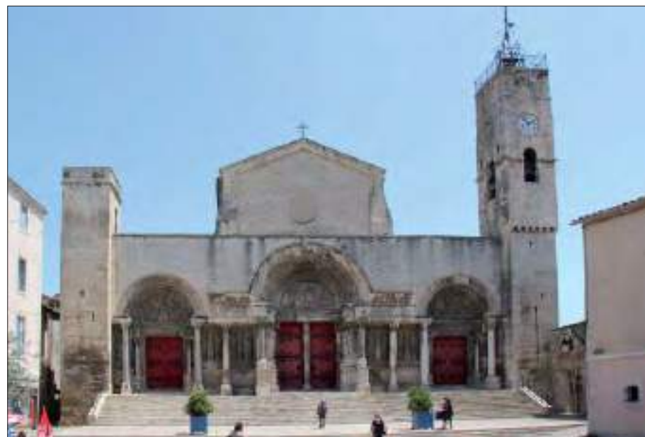
Vue générale ouest (cl. G. Danet)
