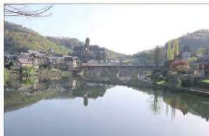
Le pont depuis la RD 920 en aval (cl. G. Danet)
