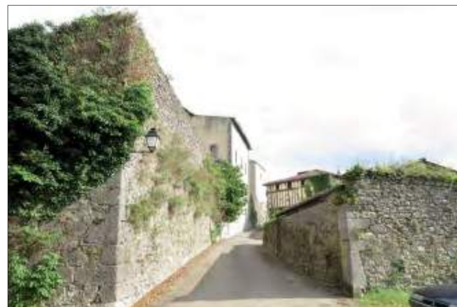
4 - Au nord, partie du rempart effondrée à la suite d'un tremblement de terre survenu en 1852 (cl. G. Danet)
