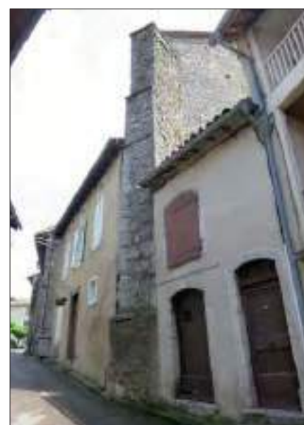
4 - Contrefort nord-ouest de la façade ouest de l'église (cl. G. Danet)
