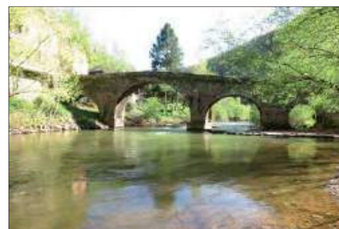
6 - Le pont, en amont du Dourdou (cl. G. Danet)
