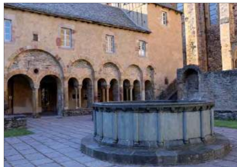
Aile ouest dite du réfectoire reconstruite à la fin du XIX e siècle et ancien bassin claustral en serpentine (cl. G. Danet)
