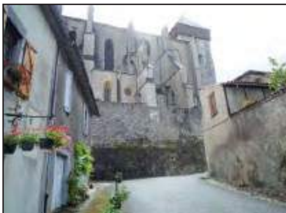
Façade nord et terrasse vue de l'impasse du Moustier (cl. G.-H. Bailly)
