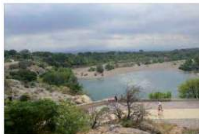
Vue générale vers l'aval du pont du Diable (cl. G. Danet)
