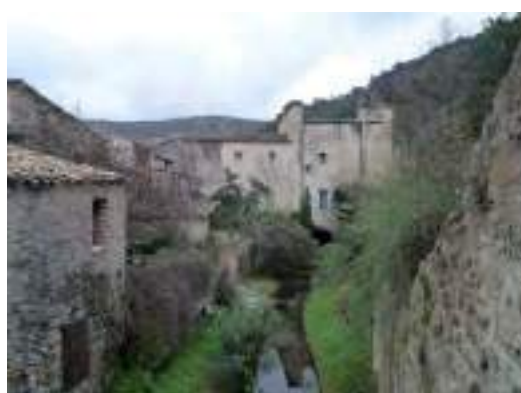
Le Verdus en amont de sa traversée souterraine de l'abbaye (cl. G.-H. Bailly)
