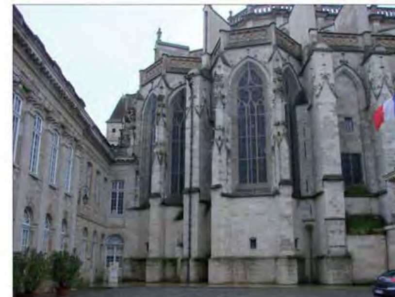
Cour de l'ancien archevêché, actuelle préfecture (ISMH, 1930/03/22) : une extension du XIX e siècle est adossée aux contreforts du chœur de la cathédrale (cl. C. Herbaut)
