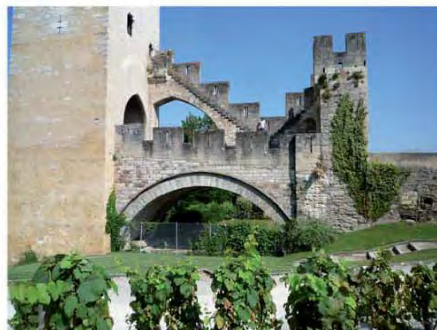
L'arche sèche entre le châtelet et la tour est (cl. G.-H. Bailly)
