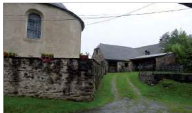
7 - Le mur d'enclos et le chemin rural nord (cl. C. Herbaut)
