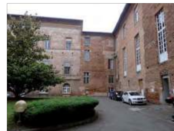
Dans la cour nord, façade ouest de l'aile est et angle de l'aile transversale (cl. C. Herbaut)
