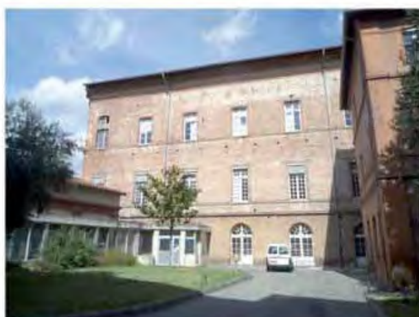
Cour arrière du côté du Port Viguerie : l'aile Est (cl. G.-H. Bailly)
