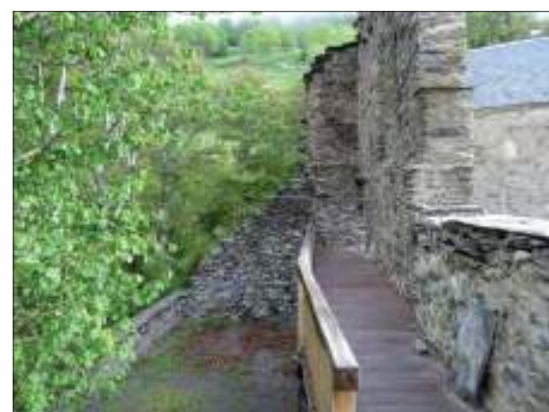
3 - Vue sud des vestiges du bâtiment de l'hôpital (cl. C. Herbaut)
