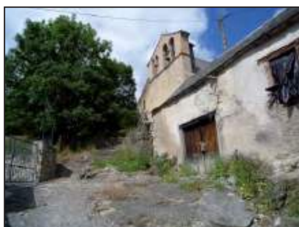
La rampe d'accès au parvis ouest de l'église (cl. G.-H. Bailly)
