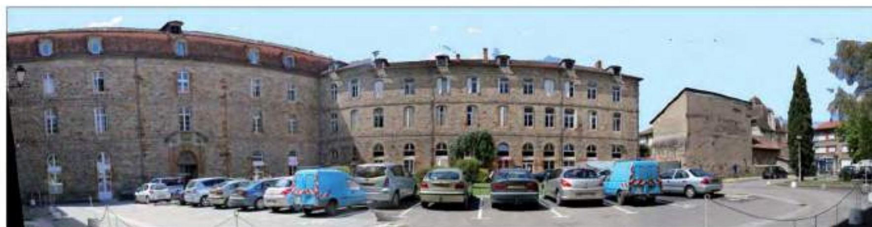
Le corps principal du bâtiment en U et l'aile ouest (cl. G.Danet)
