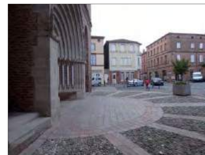
Vue d'ensemble du parvis de l'église (cl. C. Herbaut)
