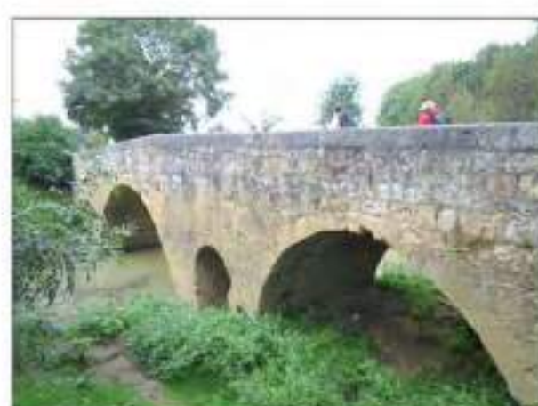
Le pont vu de l'amont depuis la rive droite (cl. G.-H. Bailly)
