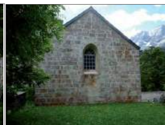
Façade nord-ouest de l'église (cl. G.-H. Bailly)
