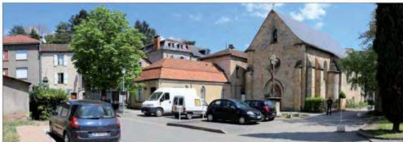
La chapelle et la croix, les pavillons d'entrée côté intérieur (cl. G. Danet)
