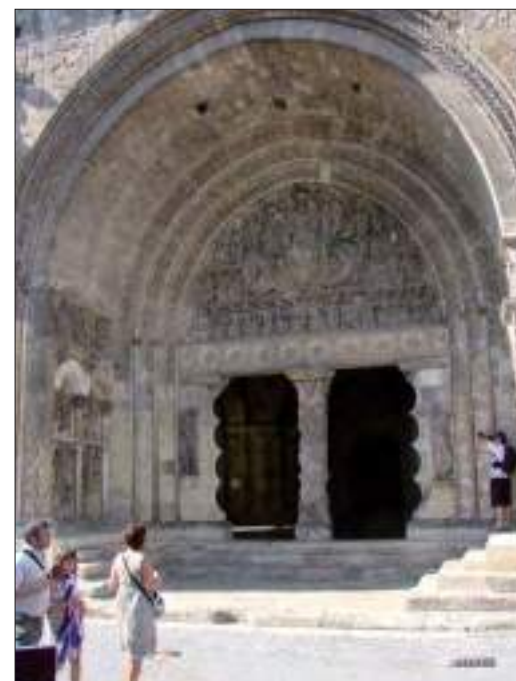
Le portail sud de la tour-porche (cl. C. Herbaut)
