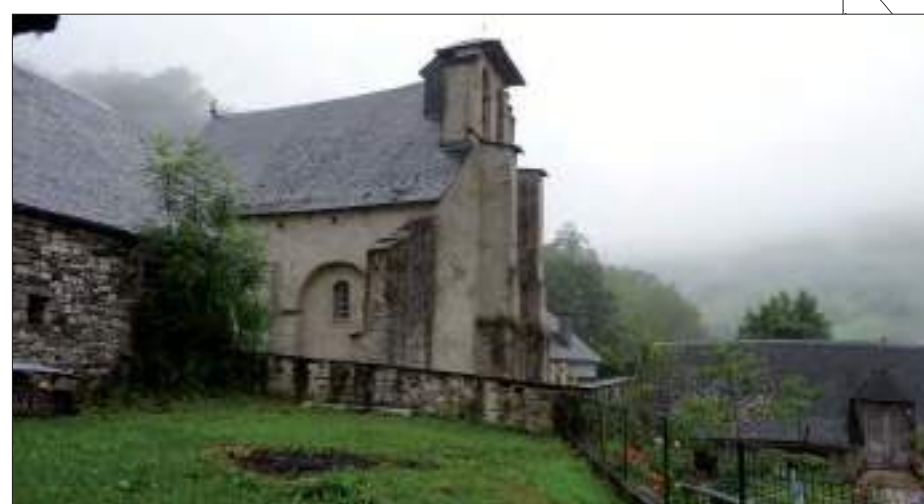
10 - Vue d'ensemble de la façade occidentale avec son clocher-mur (cl. C. Herbaut)
