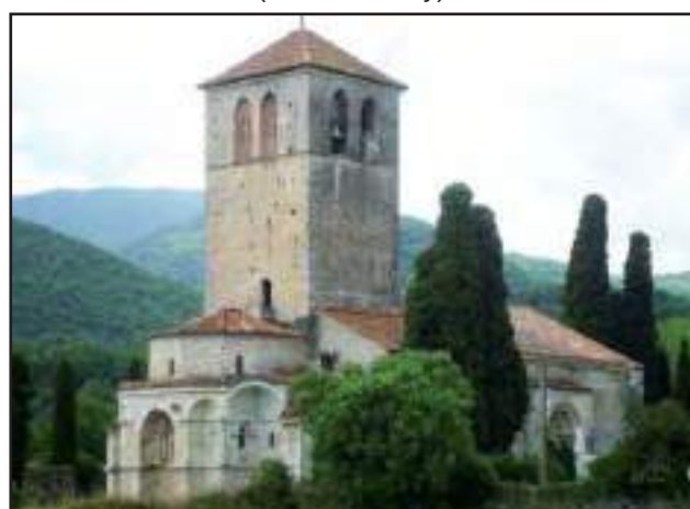
L'ensemble basilical vue depuis le nord-est (cl. G.-H. Bailly)
