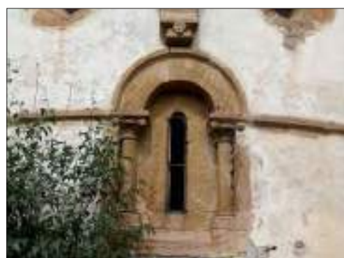
Détail de la baie axiale du chevet roman (cl. C. Herbaut)
