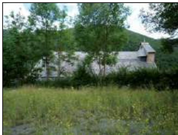
Le toit de l'église vu depuis un jardin au nord (cl. G.-H. Bailly)
