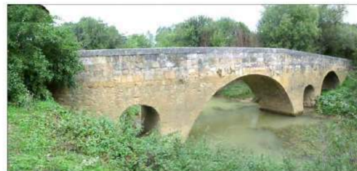
Le pont vu de l'amont est depuis la rive gauche (cl. G.-H. Bailly)
