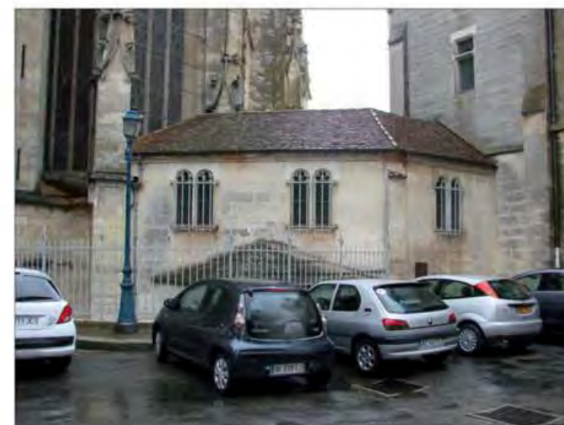
Place Salinis, extension de la sacristie construite au XIX e siècle dans le cadre du programme de dégagement de la cathédrale (cl. C. Herbaut)
