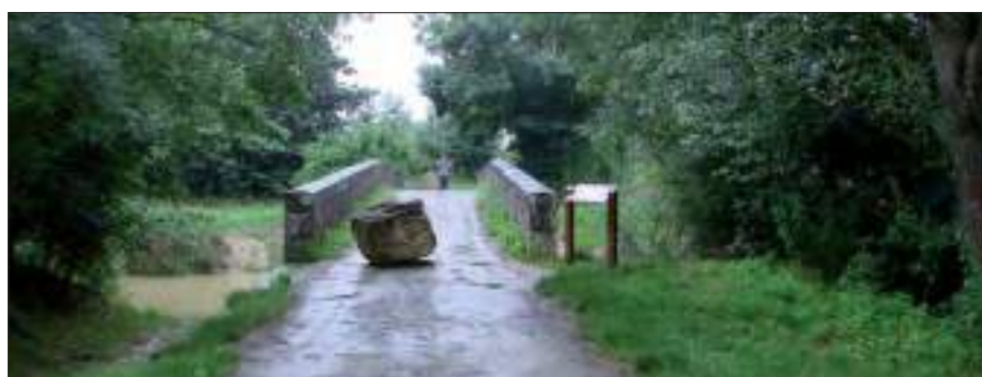
Vues en approche du pont depuis la rive droite côté Larressingle (cl. C. Herbaut)
