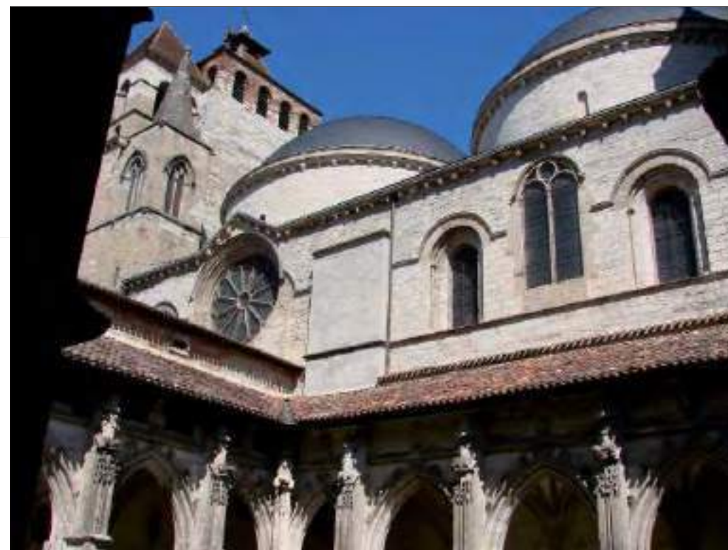
La nef et ses coupoles vues depuis le cloître (cl. C. Herbaut)
