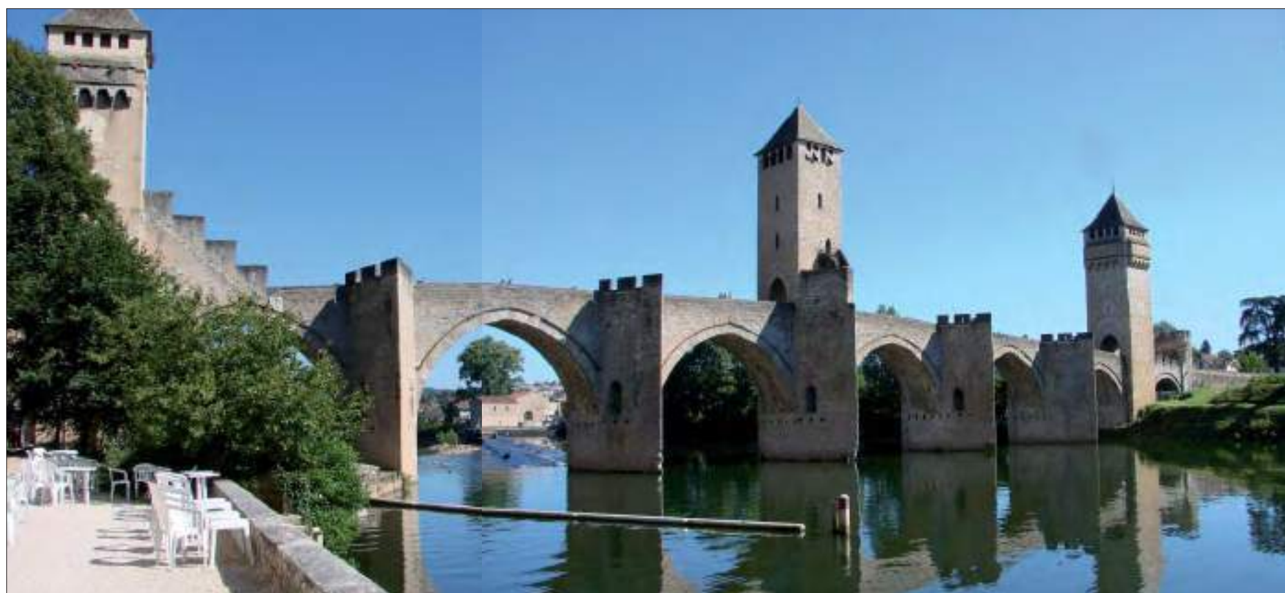
Vue générale du pont depuis l'ancienne station de pompage (1853) de la rive gauche du Lot (cl. C. Herbaut)
