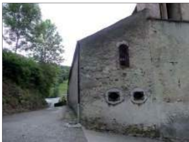
2 - Angle nord-ouest de l'église, détail de la partie XIXe siècle du bas côté nord (cl. C. Herbaut)
