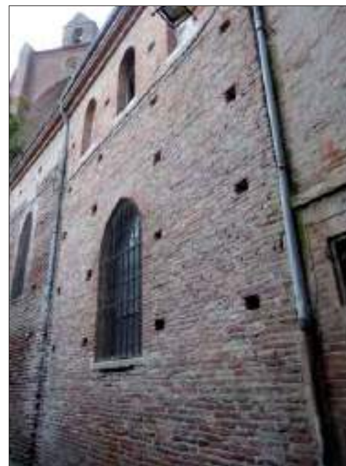
Rue du Prieuré, les façades orientales de la sacristie du XIX e siècle et de la chapelle nord accolée au chœur de l'église (cl. C. Herbaut)
