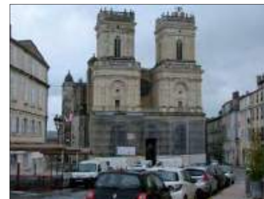
Façade occidentale de la cathédrale place de la République (cl. C. Herbaut)
