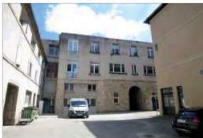
Arrière de l'aile ouest et son passage reconstruit en partie au XX e (cl. G. Danet)
