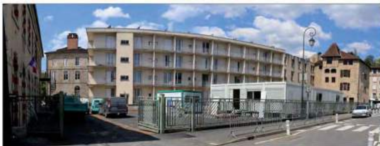
Vue sur le pignon du bâtiment principal (à gauche) depuis la rue Sainte-Marthe (cl. G. Danet)
