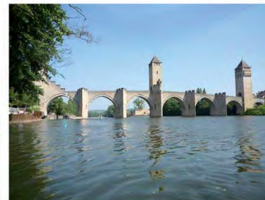
Le pont depuis la rive gauche en amont du Lot (cl. G.-H. Bailly)
