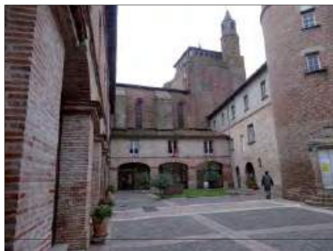
Adossés au nord de l'église les bâtiments remaniés de l'ancien prieuré, actuelle mairie. L'aile ouest et sa tour d'escalier, unique partie protégée MH, en sont les plus anciens vestiges (cl. C. Herbaut)
