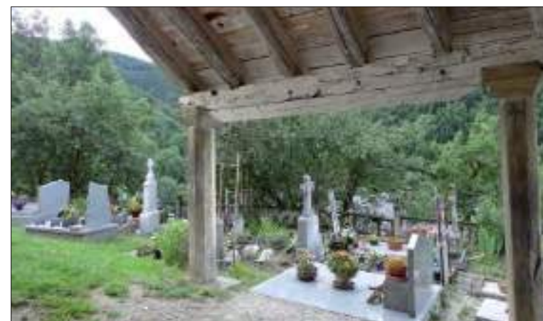
Détail des piles monolithes du porche sud (cl. C. Herbaut)
