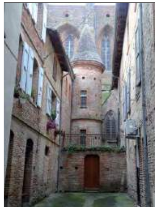
Impasse de la Mairie, dans la cour de la sacristie, la tour d'escalier du XIX e siècle distribue également le triforium de l'église (cl. C. Herbaut)
