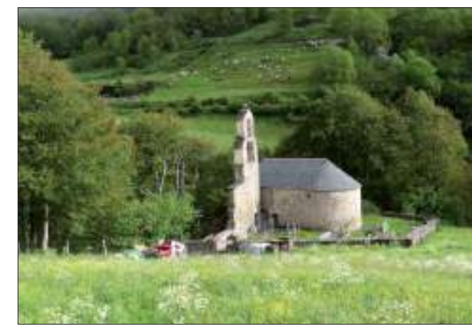
7 - Vue générale sud depuis la D.118 (cl. C. Herbaut)
