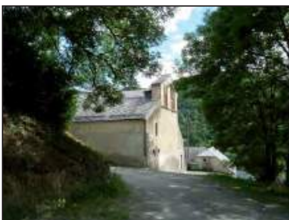
Vue depuis le chemin rural nord du pignon occidental de l'église (cl. G.-H. Bailly)
