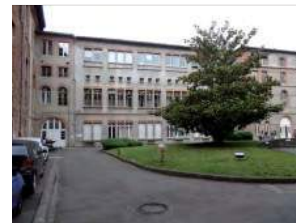
Dans la cour nord, bâtiments ouest bordant la rue Viguerie (cl. C. Herbaut)
