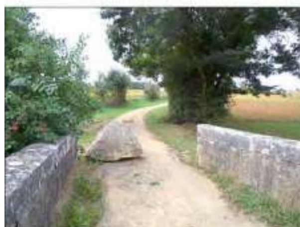
Sortie ouest du pont (cl. G.-H. Bailly)
