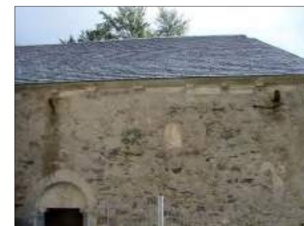
6 - Détail de l'élévation sud de la chapelle et des consoles d'un appentis disparu (cl. C. Herbaut)
