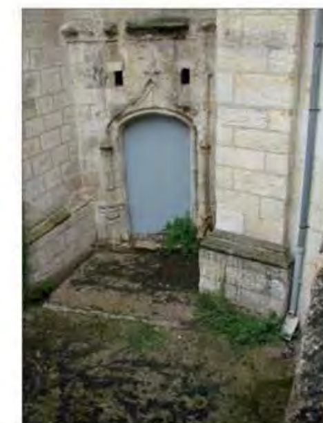
Place Salinis, dans une cour basse dépendant de la sacristie du XIX e siècle, une porte dérobée du XV e siècle donne accès à la chapelle Saint-Louis dans le déambulatoire (cl. C. Herbaut)
