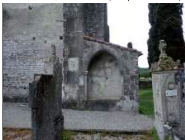
2 - Enfeu placé dans le prolongement ouest de la façade nord (cl. C. Herbaut)
