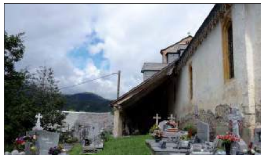
Façade sud remaniée en 1559 et son porche fin XVI e siècle abritant l'accès à la porte de l'église et quelques sépultures (cl. C. Herbaut)
