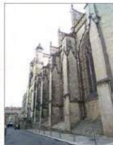
La façade nord avec ses glacis entre les contreforts de la nef (cl. G.-H. Bailly)
