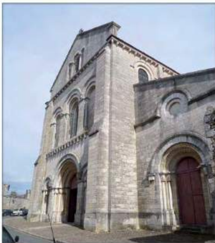
Façade ouest (cl. G.-H. Bailly)
