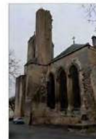
7 - Chevet de l'église du XIX e et piles d'arcs-boutants gothiques
