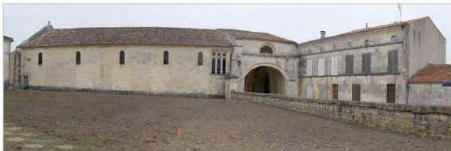
Vue de la façade sud de la salle des Malades (cl. G. Danet)
