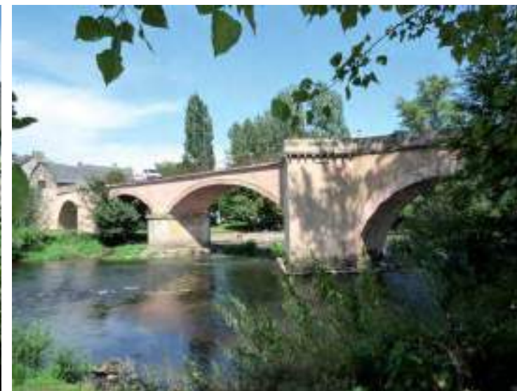
N° 3 - Le pont de la route D 6 à la sortie de la ville (cl. G.-H. Bailly)
