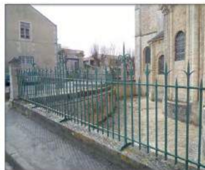
Décaissé du sol autour du chevet (cl. G.-H. Bailly)
