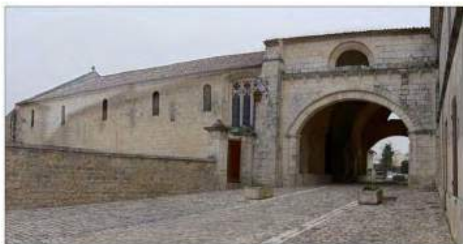
Vue de la salle des Malades et du porche - façade sud (cl. G.-H. Bailly)
