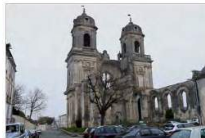
5 - La façade ouest de l'église inachevée depuis la rue d'Aguesseau (cl. G. Danet)
