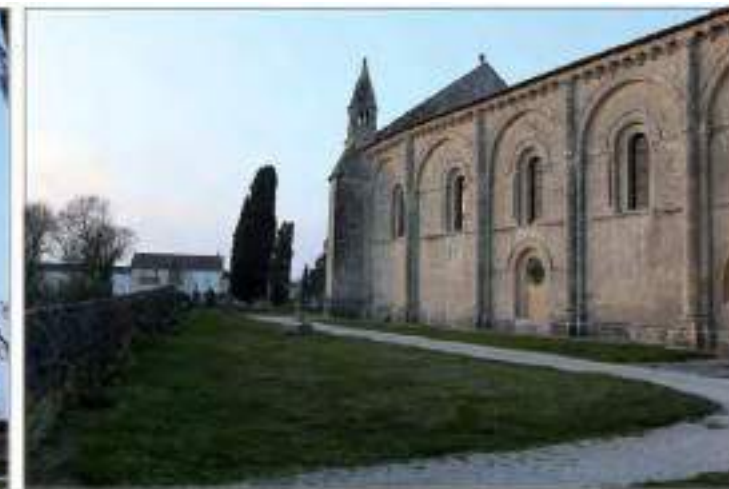
Vue de la façade sud de la nef (cl. G.-H. Bailly)
