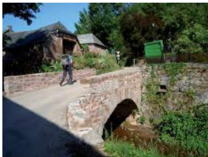
N° 37 - Le pont de Saint-Pierre de Bessuéjols sur le ruisseau d'Astruges (cl. G.-H. Bailly)
