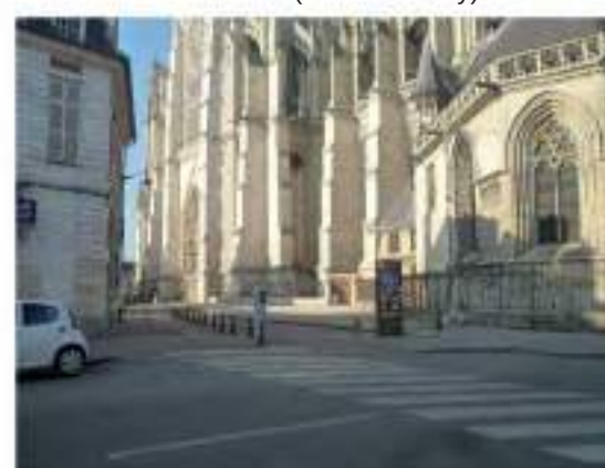
La façade Sud (cl. G.-H. Bailly)
