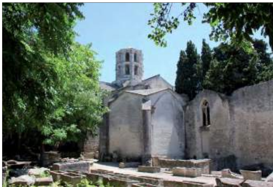
Vue générale sud-ouest (cl. G. Danet)
