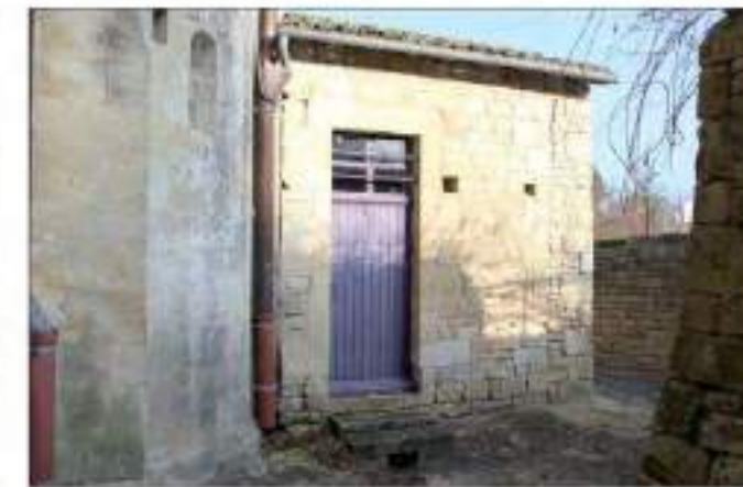
La construction annexe en adjonction à la façade sud (cl. G. Danet)
