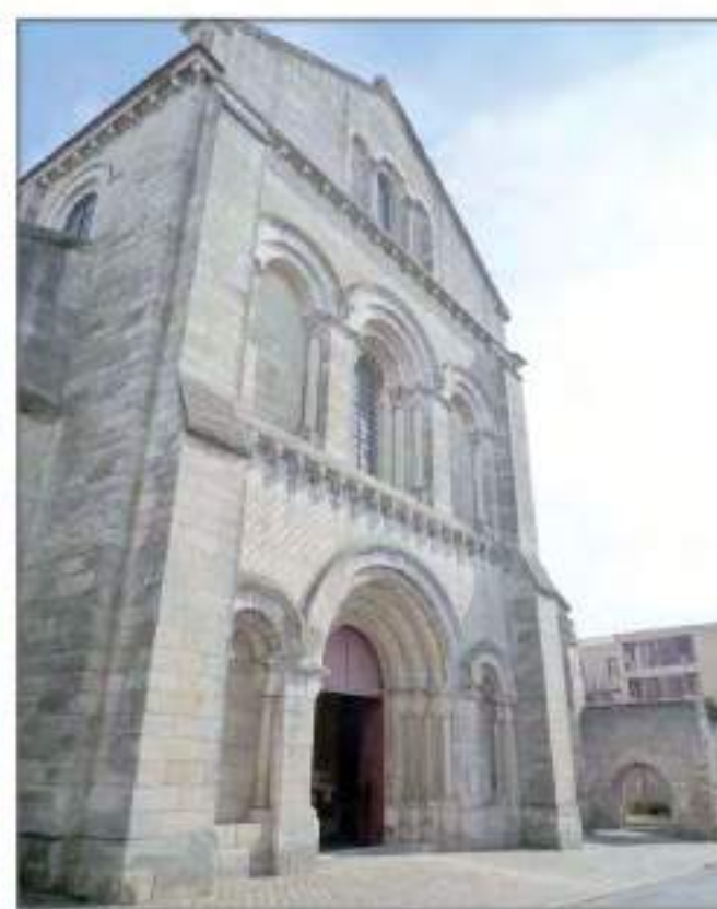
Façade ouest (cl. G.-H. Bailly)
