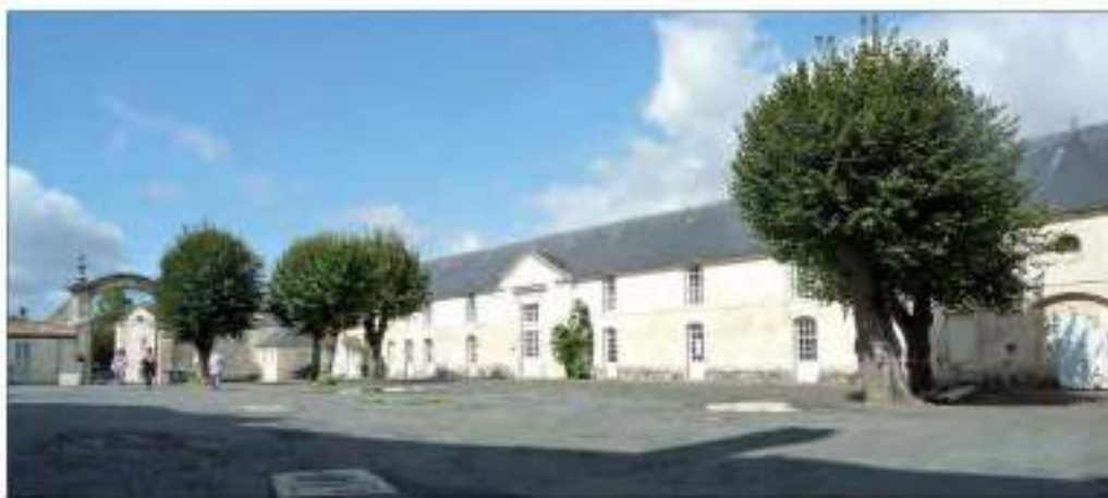
Façade du bâtiment des communs donnant sur la cour d'honneur (cl. G.-H. Bailly)
