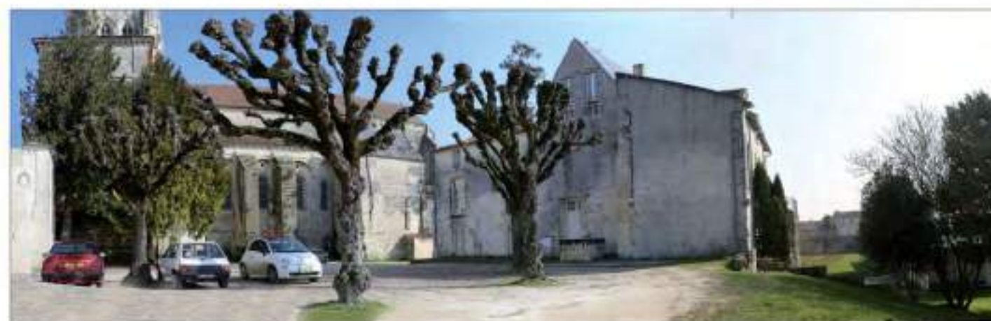
Façade sud de l'église (cl. G. Danet)
