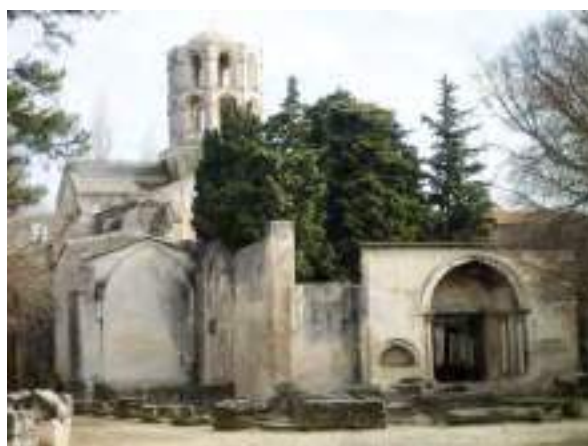
Façade ouest de l'église (cl. G.-H. Bailly)
