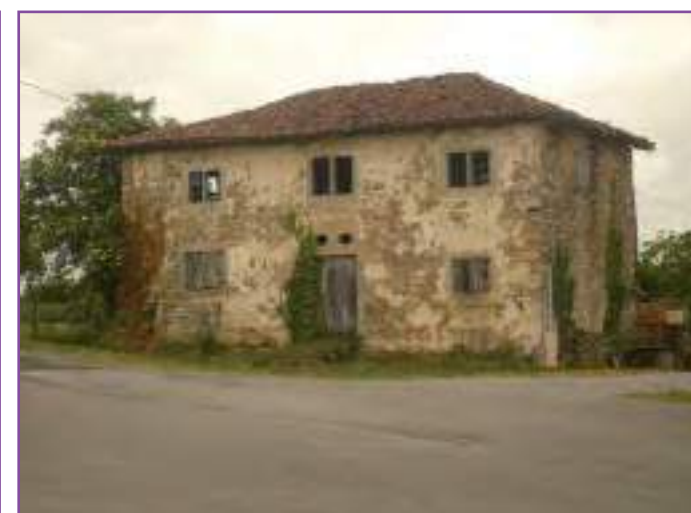
N° 58 - une maison ancienne inhabitée de Larribar-Sorhapuru (cl. G.-H. Bailly)
