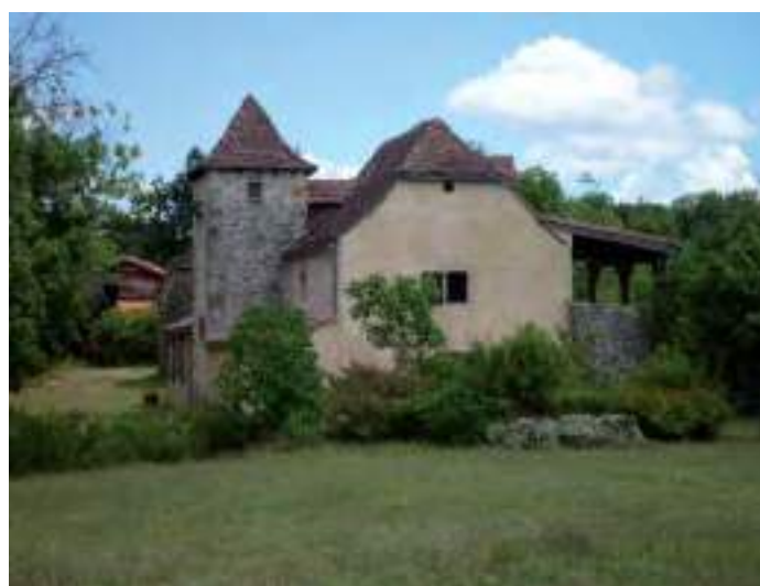
N°46 - Une ferme caractéristique de l'architecture locale au bord du chemin (cl. G.-H. Bailly)
