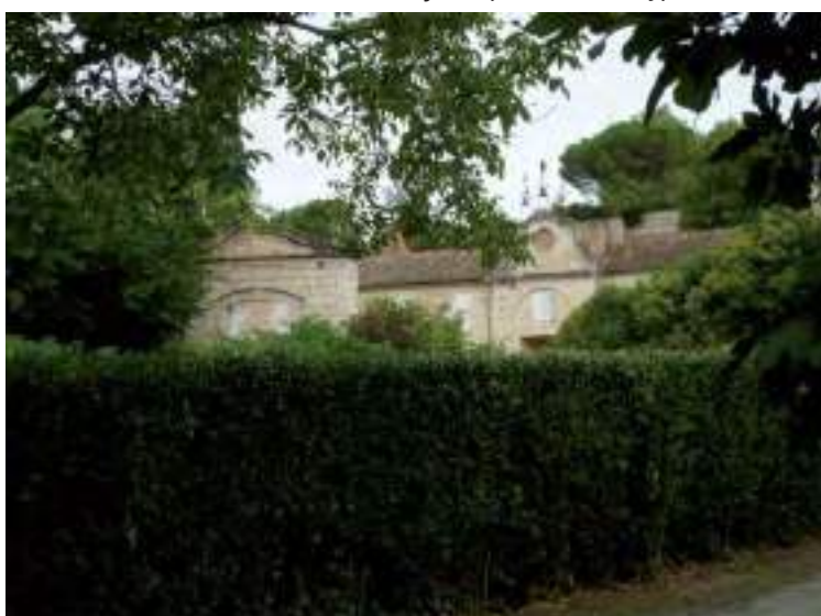
N° 5 - La façade sud et le campanile de l'ancienne tannerie royale (cl. G.-H. Bailly)
