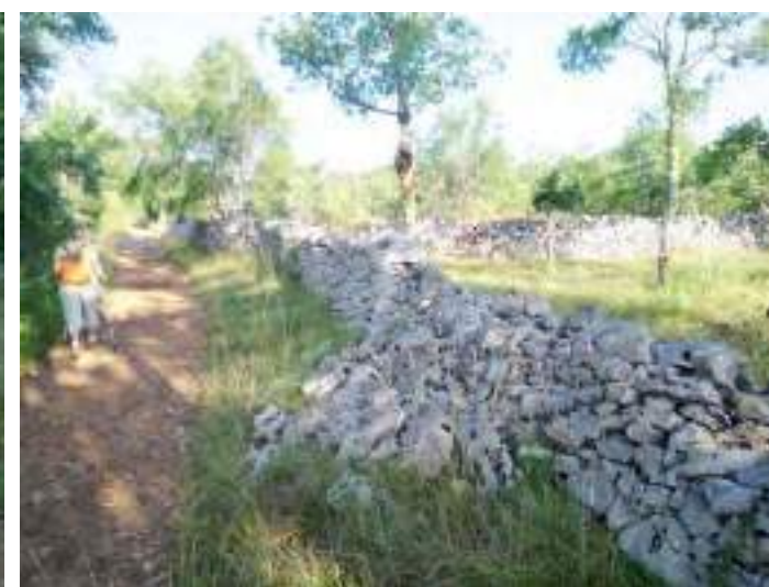
N°15 - Les murets de pierres sèches sont souvent en mauvais état (cl. G.-H. Bailly)
